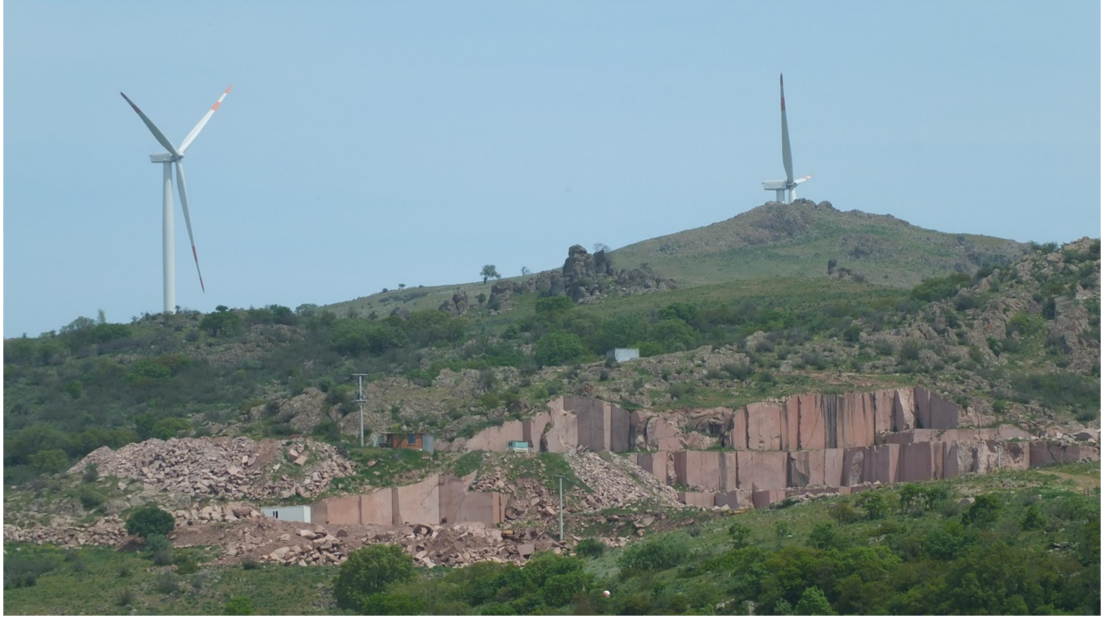
Şekil 38: Ayvatlar Kırsal Mahallesi girişinde andezit taş ocağı (VIII. sınıf arazi)
