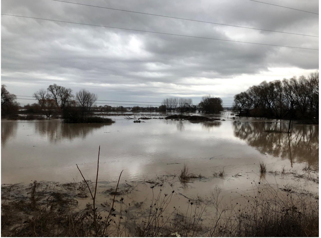
Şekil 34: Üzümcü Çayı'nın 11 Ocak 2019 taşkını Küçükbostancı köprüden
