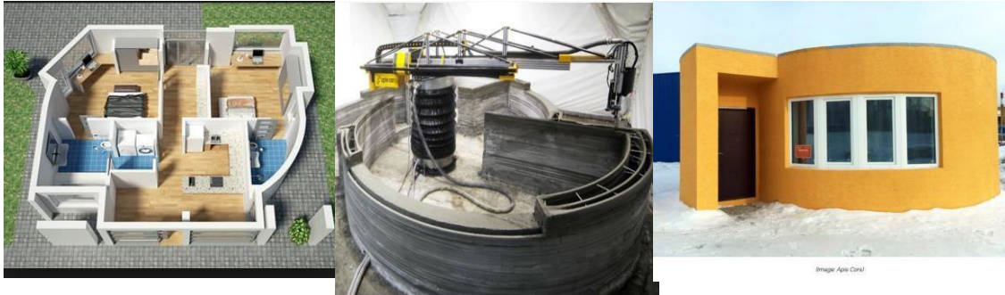
Şekil 2.3: 3B ile inşa edilmiş “ Apis Cor House ”, Rusya.
