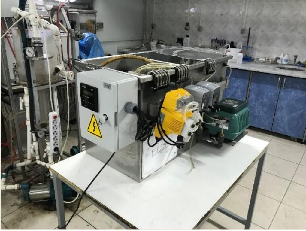
Şekil 3.1: MBR sistemi yan görünüşü.
