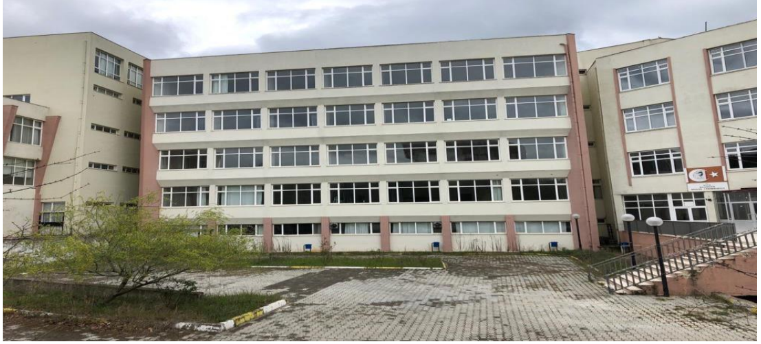
Şekil 4.4: D blok ön cepheden görünüş
