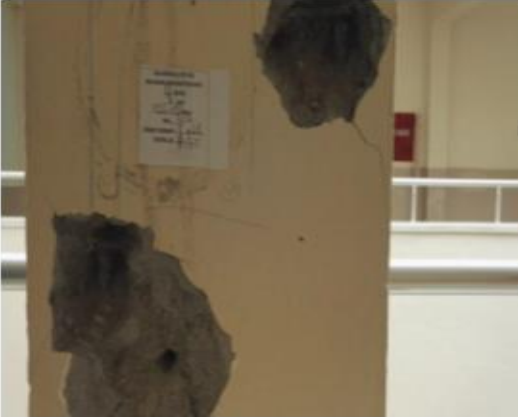
Şekil 4.10: İncelenen yapıda kolonlarda pas payı sıyırma ile donatı tespiti.
