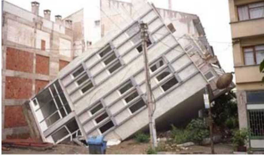
Şekil 7.8: 1999 depreminde zemin sıvılaşmasından hasar gören bir bina (Adapazarı).
