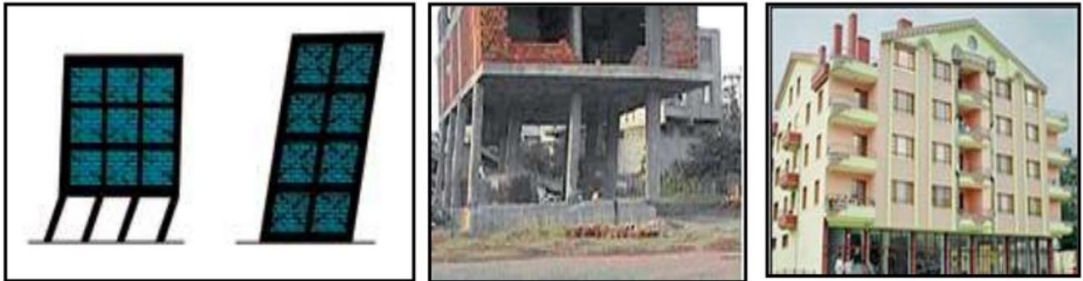
Şekil 7.5: Yumuşak ve Zayıf kat Örnekleri a) Dolgu duvar süreksizliği durumunda deprem davranışı, b)yumuşak kat oluşumu hasarları, c) giriş katında dolgu duvar bulunmayan konut.
