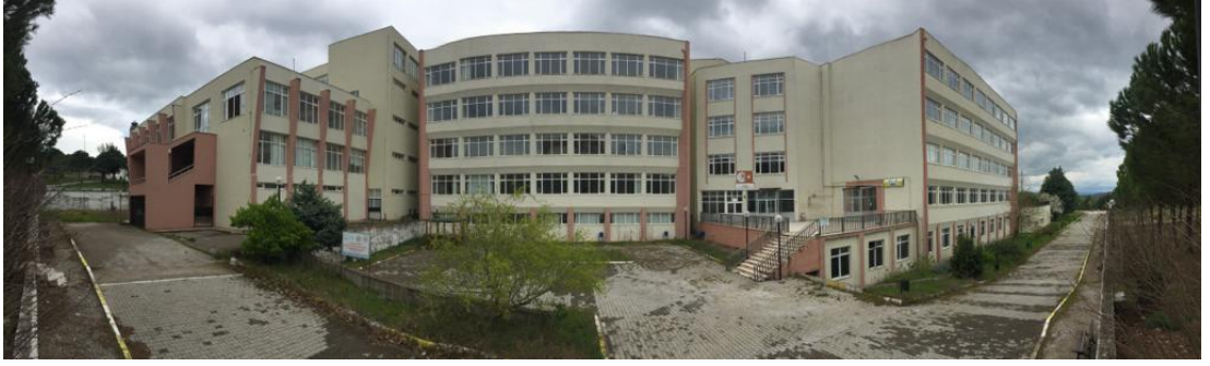
Şekil 4.2: Binanın genel görünüşü.
