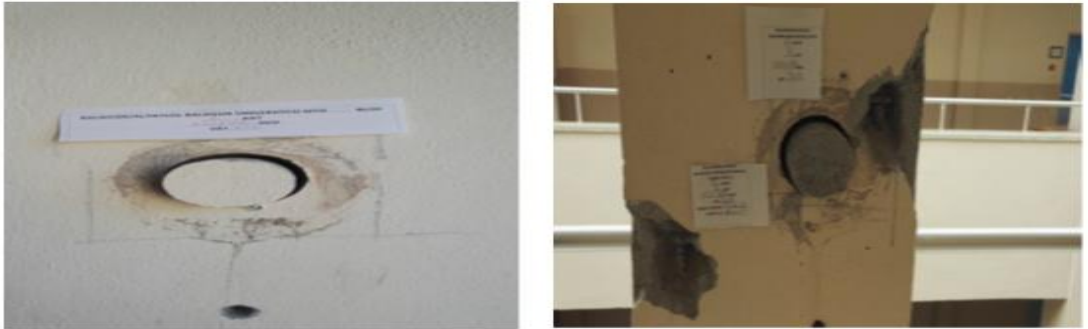
Şekil 4.9: İncelenen yapıdan alınan karot numuneler.
