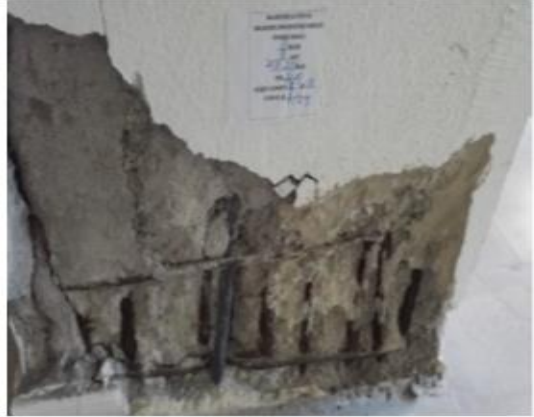
Şekil 4.10: İncelenen yapıda kolonlarda pas payı sıyırma ile donatı tespiti.
