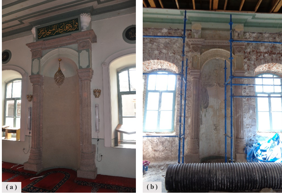
Şekil 4.60: İbrahim Bey Cami mihrabı; (a) raspa öncesi, (b) raspa sonrası ortaya çıkan kalem işi.
