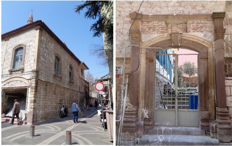
Şekil 4.55: İbrahim Bey Cami doğu cephesi ve avluya giriş kapısı.
