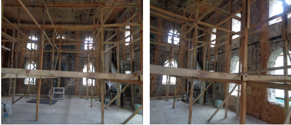
Şekil 4.76: Halhallı Camisinin restorasyon çalışmalarında içerden görünümü.
