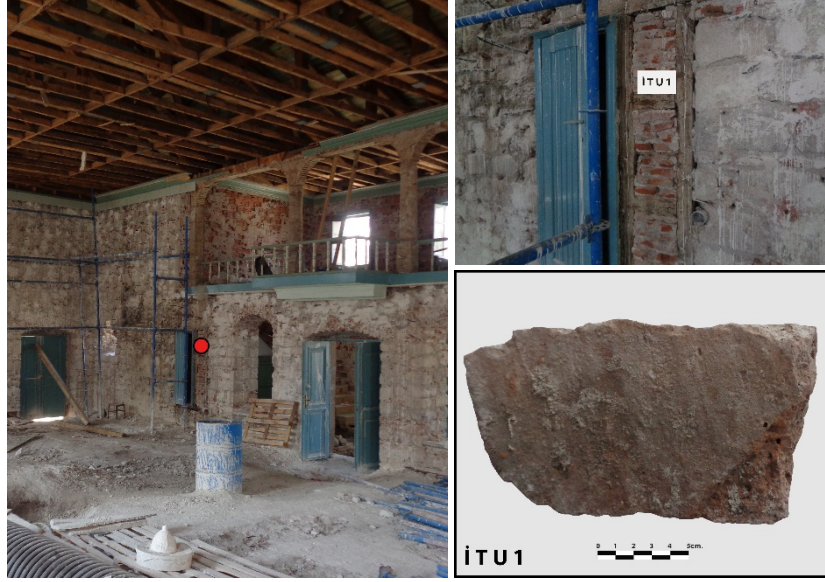
Şekil 5.19: İTU1 numunesi ve yapıdaki yeri.
