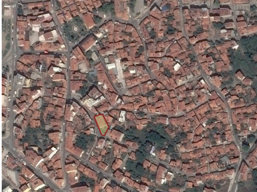
Şekil 4.62: Vakıf Mahallesi Halhallı Camisini gösteren hava fotoğrafı (Google Earth 09.02.2019).
