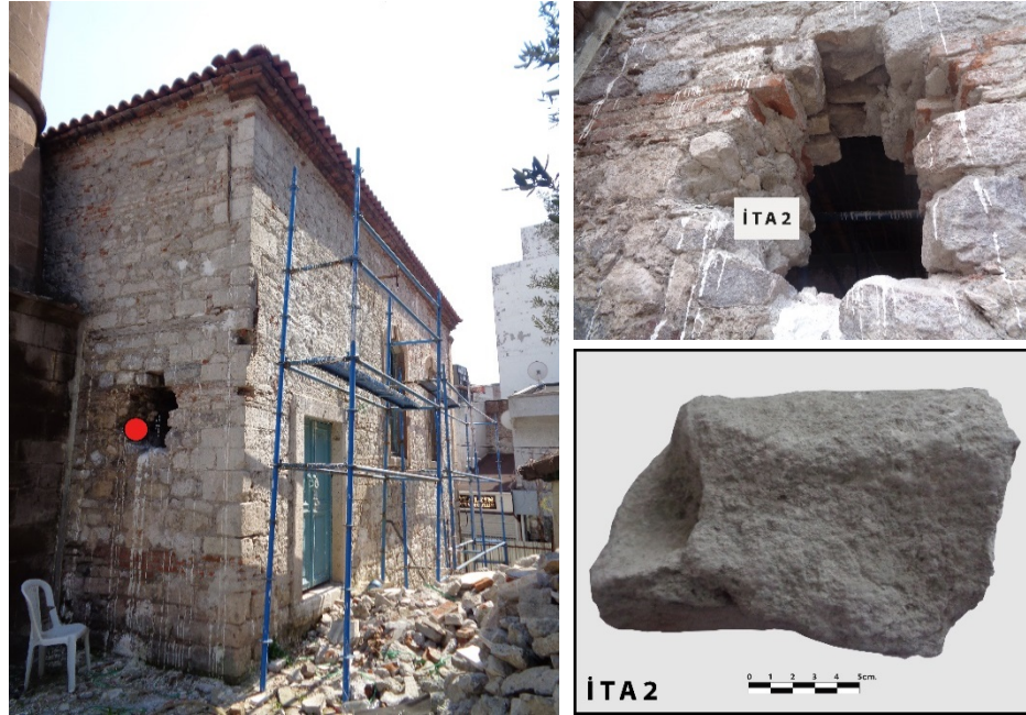
Şekil 5.18: İTA2 numunesi ve yapıdaki yeri.
