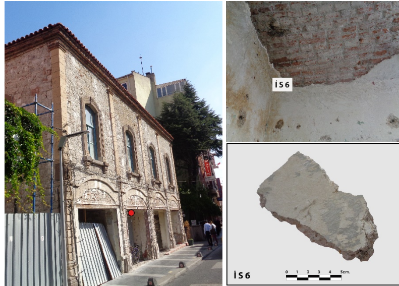
Şekil 5.30: İS6 numunesi ve yapıdaki yeri.
