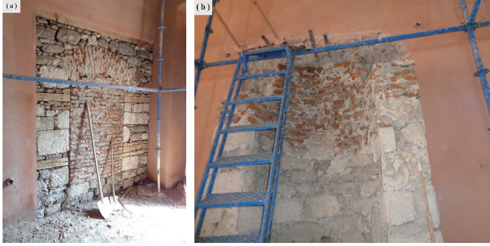
Şekil 4.33: (a) Kaya Bey Cami kuzey beden duvarı örgüsü, (b) Mihrapta yapılan raspa sonrası ortaya çıkan tuğla ve taş örgüsü.
