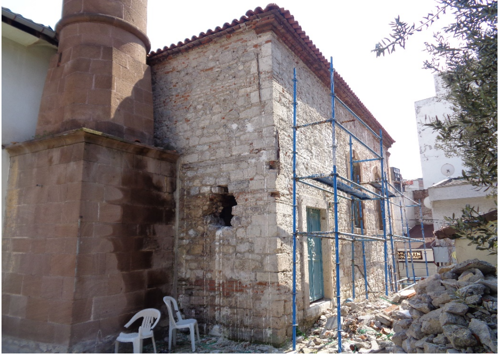
Şekil 4.56: İbrahim Bey Cami batı cephesi.
