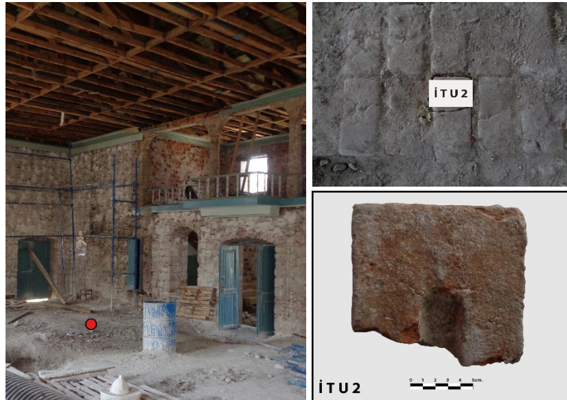
Şekil 5.20: İTU2 numunesi ve yapıdaki yeri.
