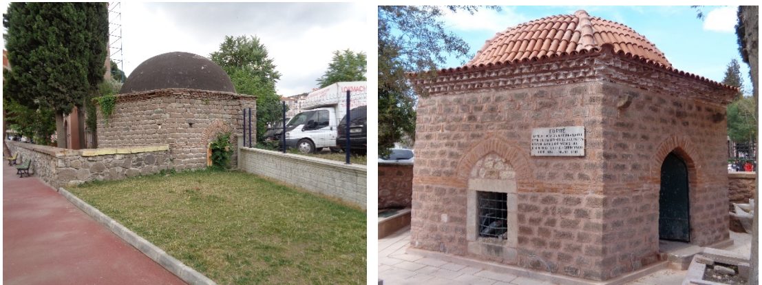
Şekil 4.31: Üçpınarlıoğlu Türbesi restorasyon öncesi ve sonrası.
