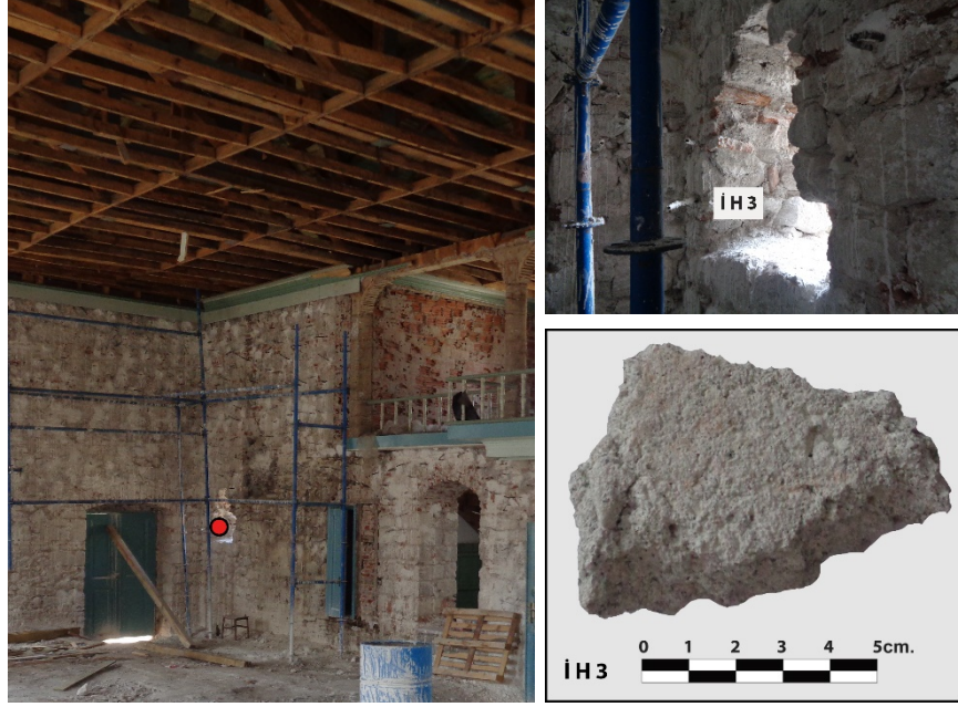
Şekil 5.23: İH3 numunesi ve yapıdaki yeri.
