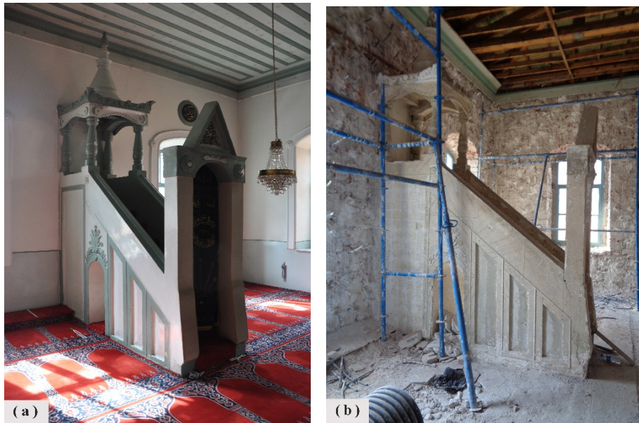
Şekil 4.61: İbrahim Bey Cami minberi; (a) raspa öncesi, (b) raspa sonrası ortaya çıkan mermer taklidi yüzey.
