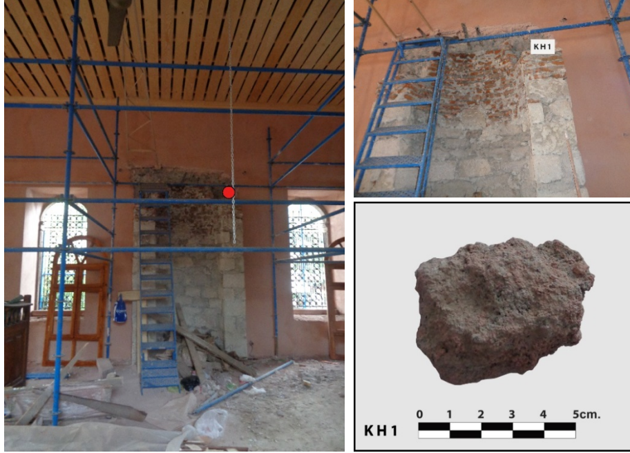
Şekil 5.9: KH1 numunesi ve yapıdaki yeri.
