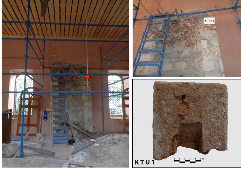
Şekil 5.7: KTU1 numunesi ve yapıdaki yeri.
