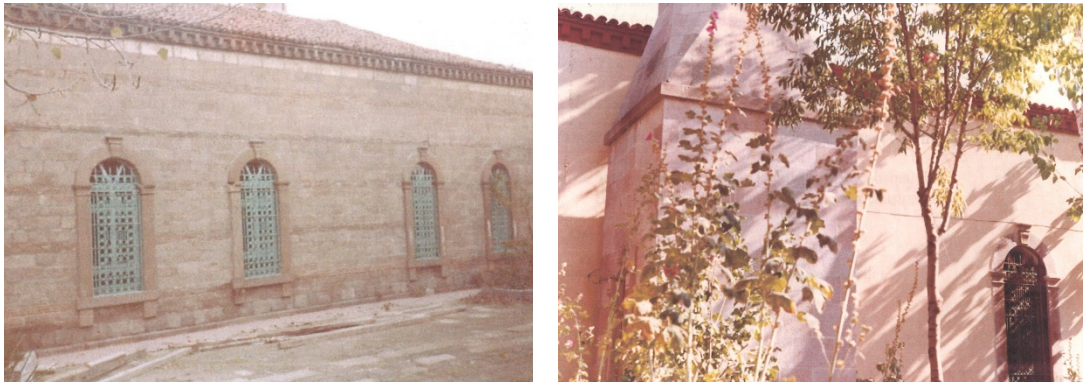
Şekil 4.16: Kaya Bey Camisinin 1986 tarihli onarım sonrası güney ve kuzey cepheleri (BVBM arşivi).
