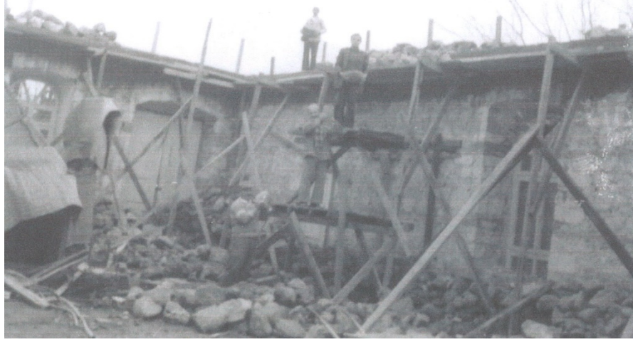
Şekil 4.12: Kaya Bey Camisinin 1986 yılında yapılan esaslı onarımda içerden görünümü (BVBM arşivi).
