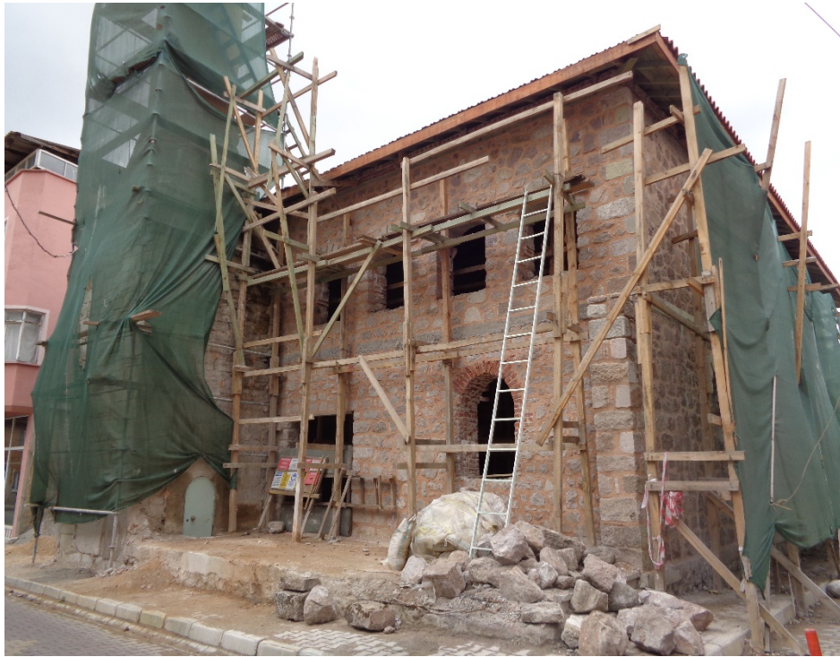
Şekil 4.77: Halhalı Cami kuzey cephesi.
