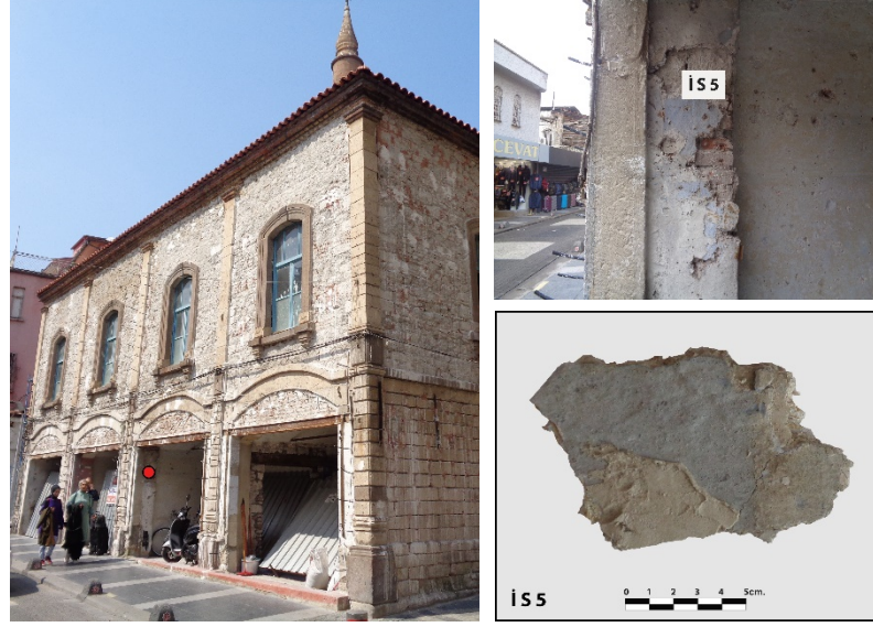
Şekil 5.29: İS5 numunesi ve yapıdaki yeri.
