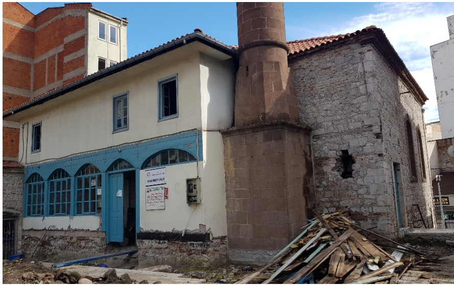
Şekil 4.53: İbrahim Bey Cami kuzey cephesi.
