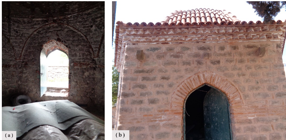
Şekil 4.34: (a) Üçpınarlıoğlu Türbesi kubbeyi taşıyan kemerler (b) beden duvarı örgüsü.
