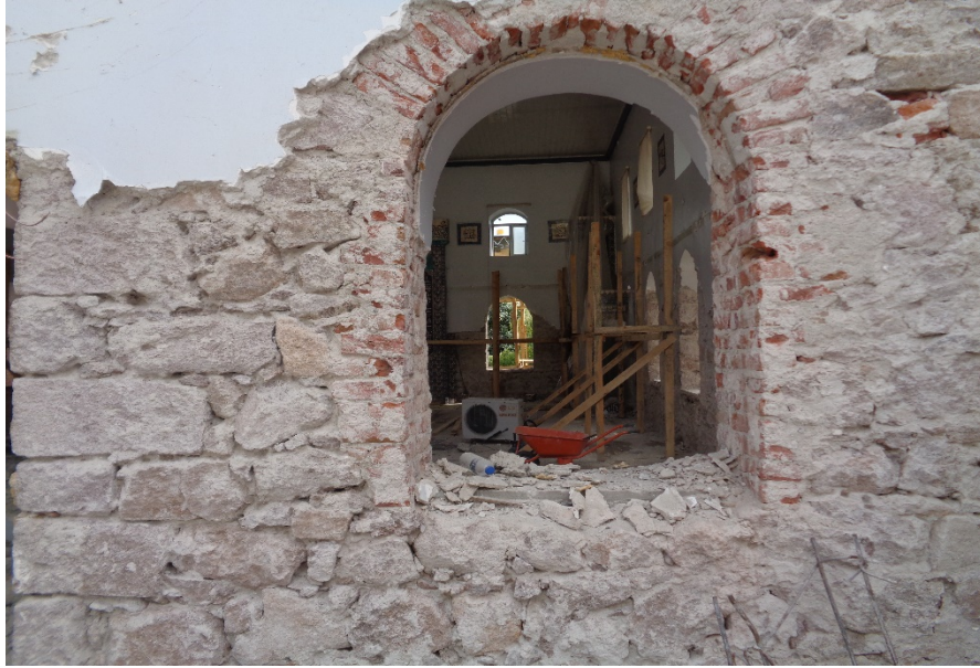
Şekil 4.81: Halhallı Cami kuzey cephe beden duvarındaki taş-tuđla örgüsü.
