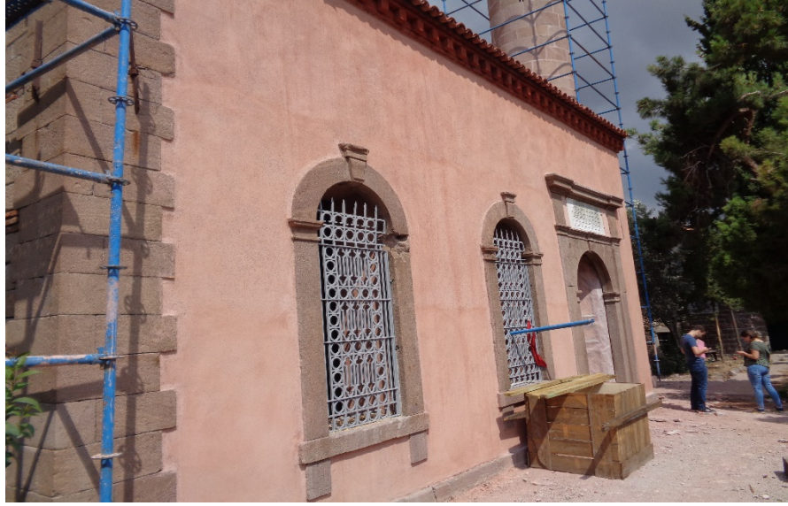
Şekil 4.25: Kaya Bey Cami doğu cephesi.
