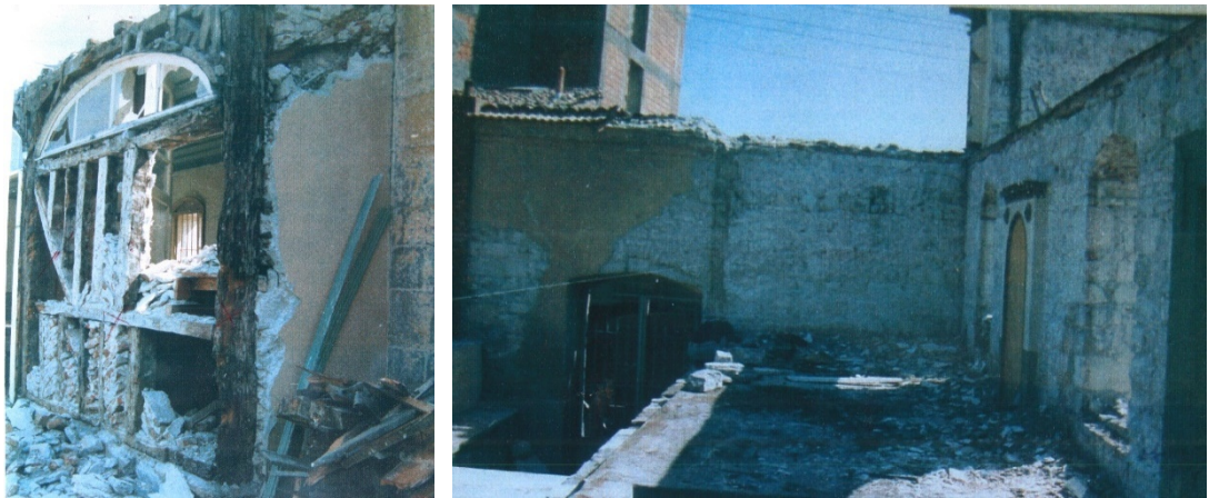
Şekil 4.43: İbrahim Bey Camisinin 1992 yılında yapılan esaslı onarımda son cemaat mahallinin tamamen yıkıldığını gösteren fotoğraflar (BKVKBK arşivi).
