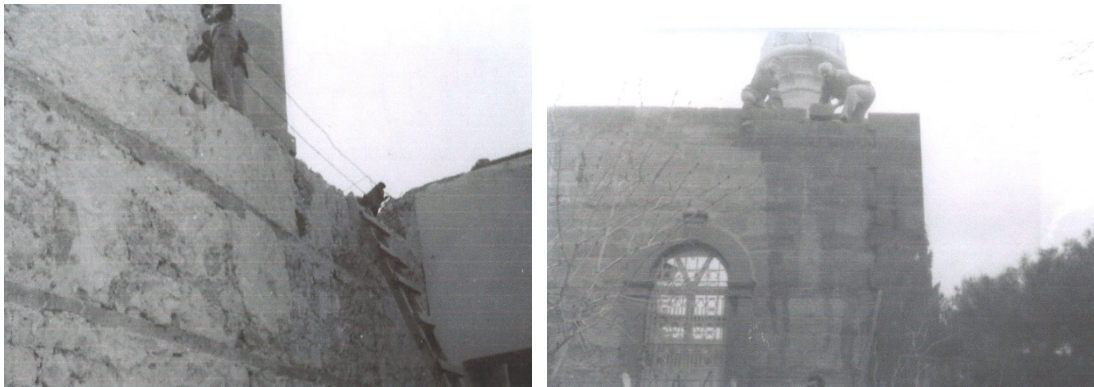
Şekil 4.14: Kaya Bey Camisi yıkılan duvarların yeniden örülmesi (1986 tarihli fotoğraf BVBM arşivi).
