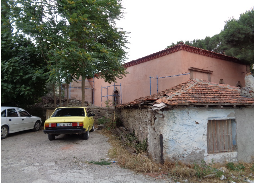
Şekil 4.28: Kaya Bey Cami kuzey cephesi.
