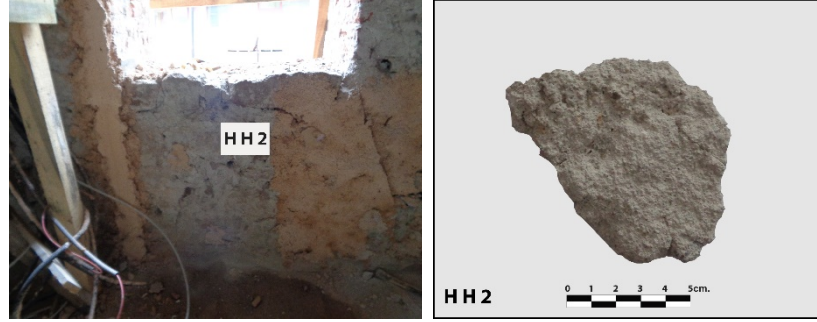
Şekil 5.38: HH2 numunesi ve yapıdaki yeri.
