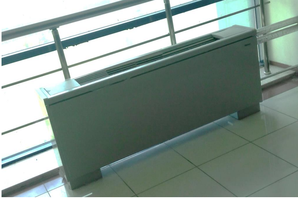
Resim 3.13: Rektörlük binasında bulunan mevcut fan coil.
