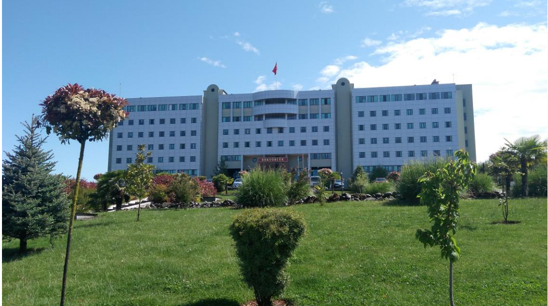
Resim 3.10: Rektörlük binası genel görünüşü.
