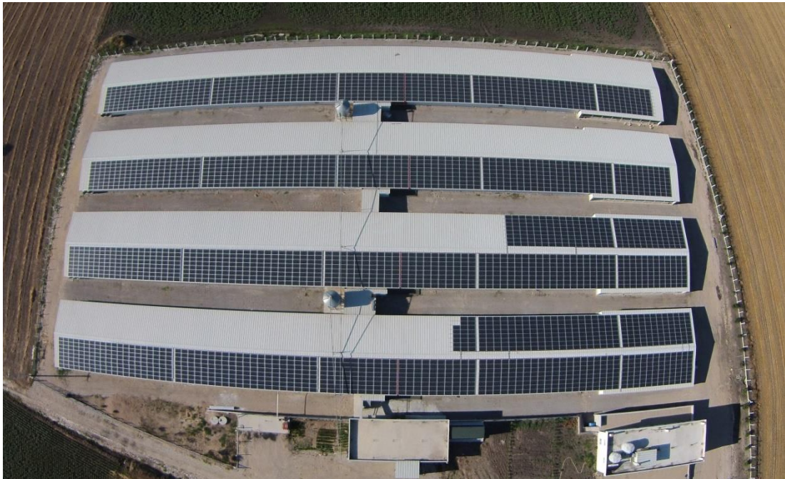
Şekil 4.16: Aydın Dölger GES Tesisı
