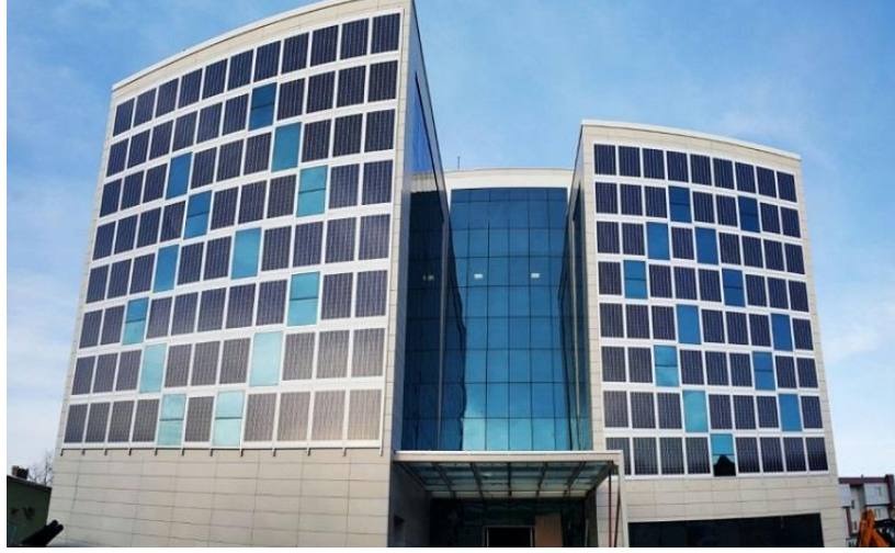
Şekil 3.18: PV modüllerin bina dış yüzeyine uygulanması
