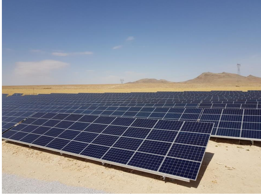
Şekil 3.21: PV modüllerin araziye uygulanması
