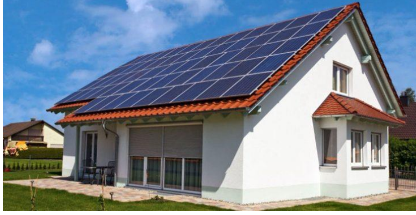
Şekil 3.19: PV modüllerin eğimli çatıya uygulanması
