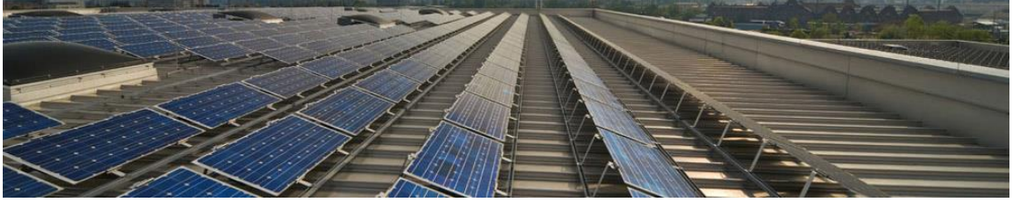
Şekil 3.20: PV modüllerin düz çatıya uygulanması
