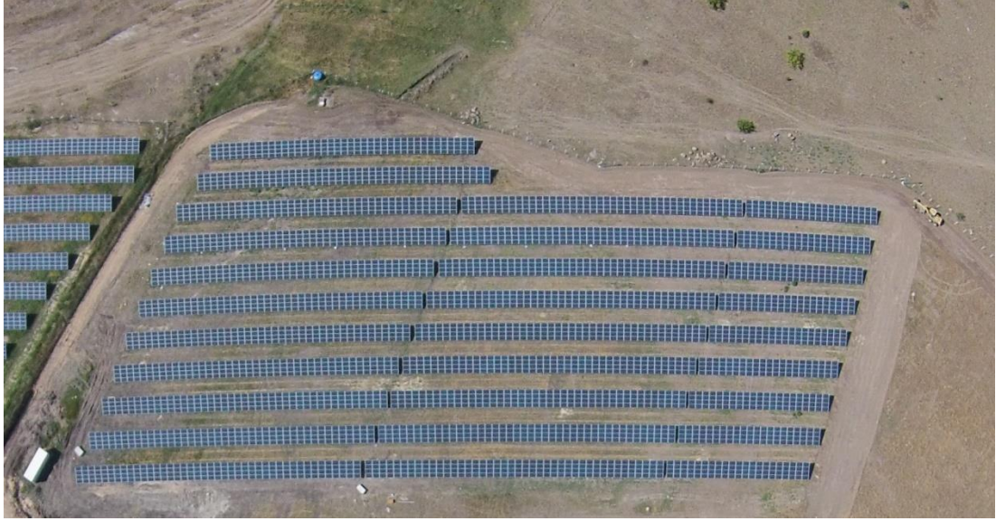
Şekil 4.15: Albatır Enerji GES Tesisı
