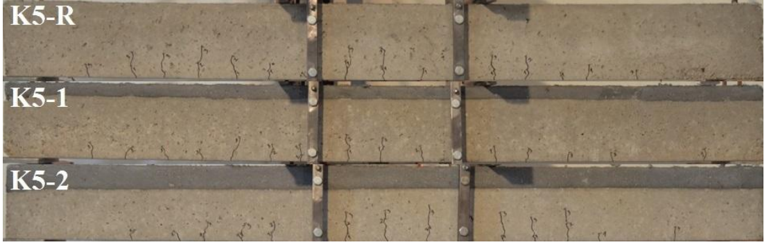
Şekil 2.34: K5 ( \rho=0.0407 ) kirişlerine ait çatlak dağılımları ( L/250 yerdeğiřtirmesi).
