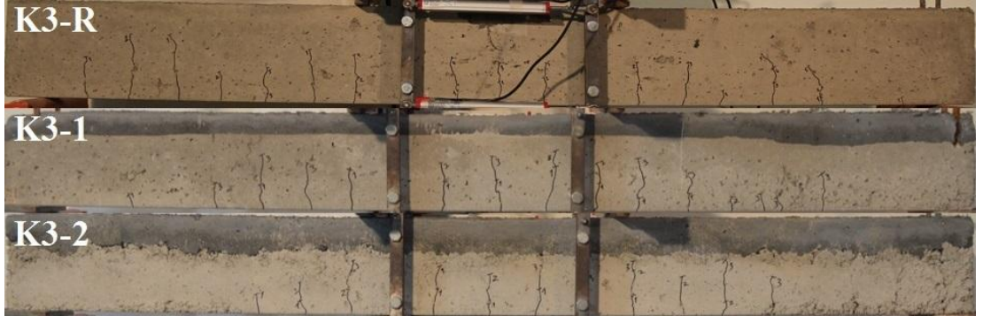
Şekil 2.28: K3 ( \rho=0.0242 ) kirişlerine ait çatlak dağılımları ( L/250 yerdeğiřtirmesi).
