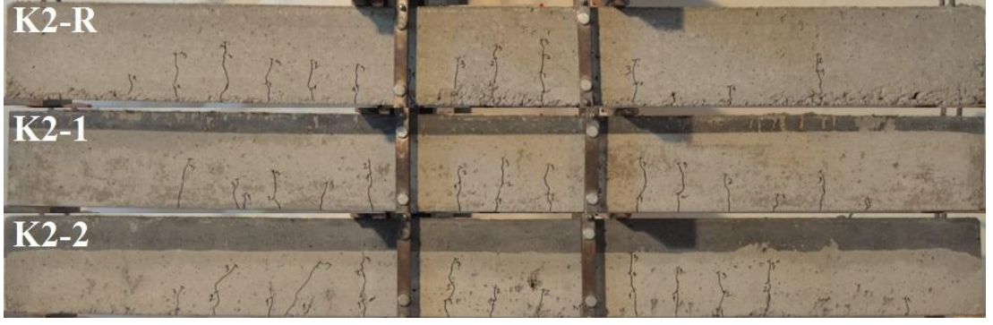
Şekil 2.25: K2 ( \rho=0.0177 ) kirişlerine ait çatlak dağılımları ( L/250 yerdeğiřtirmesi).
