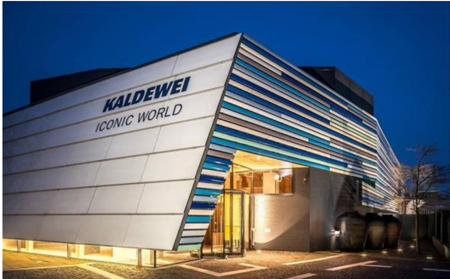
Şekil 4.6. Kaldewei Competence Center Binası (URL-15).
