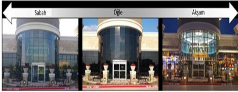
Şekil 4.10. Termokromik bir binanın sabah, öğle ve akşam görünümü (URL-18).
