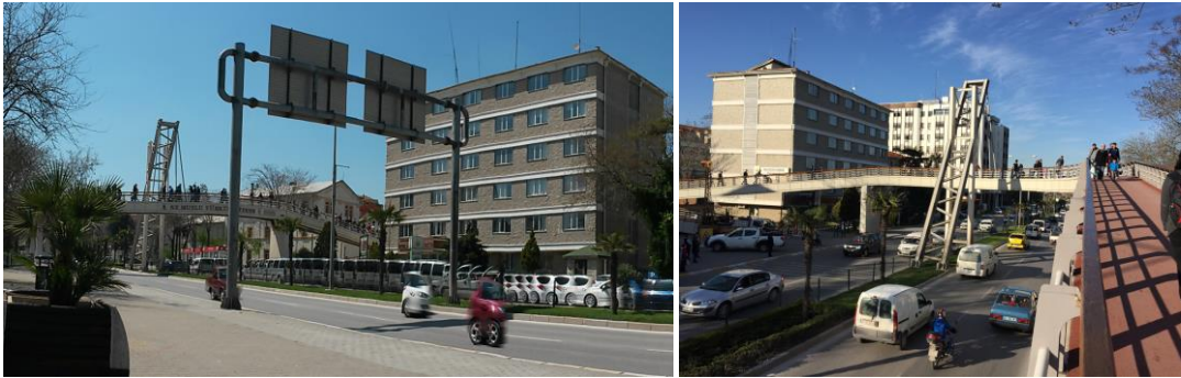
Şekil 6. Mevcut yaya köprüsü
