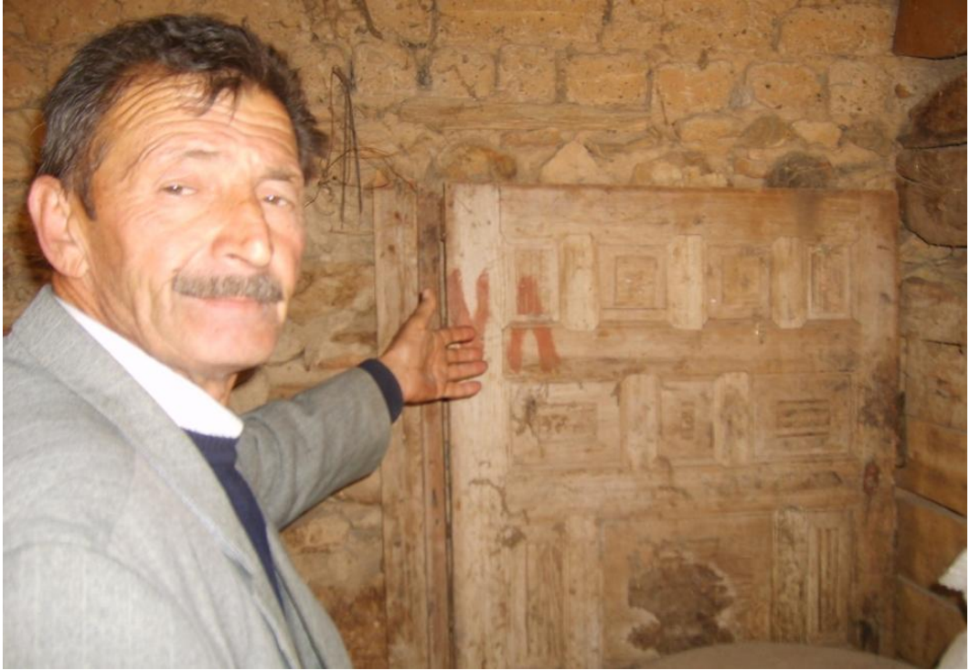
Şekil 4.8: Eskiden çivi kullanılmadan 40 parça kızılçam ( Pinus brutia )'dan yapılmış kapı (Gülpınar köyü).
