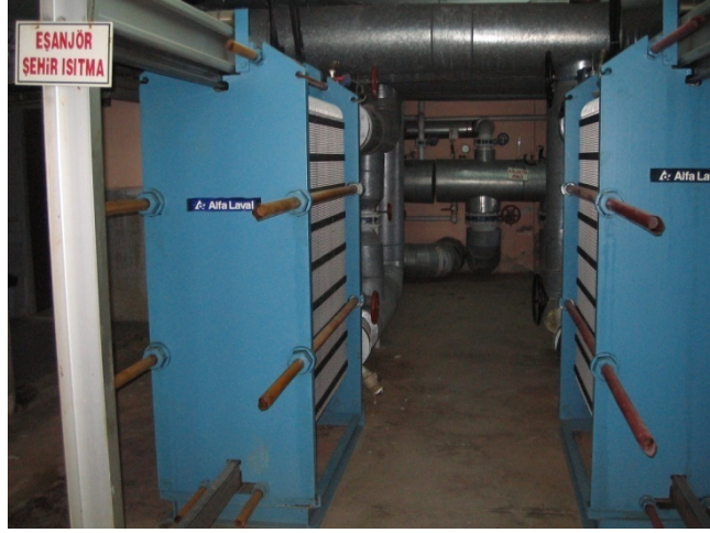
Şekil 2.6 Isı merkezinde kullanılan plakalı eşanjörler.
