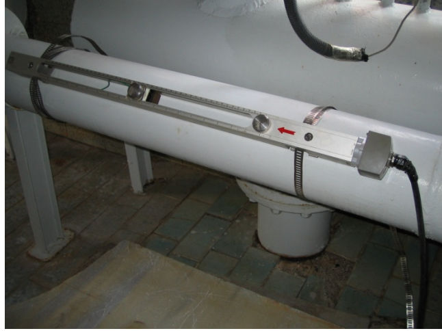
Şekil 2.10 Ultrasonik debimetre ile boru yüzeyinden debi ölçümü.
