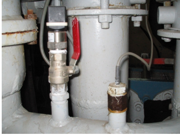
Şekil 2.7 Eşanjör çıkış borusu üzerine sıcaklık probu ve basınç transmitterinin monte edilmiş görünüşü.
