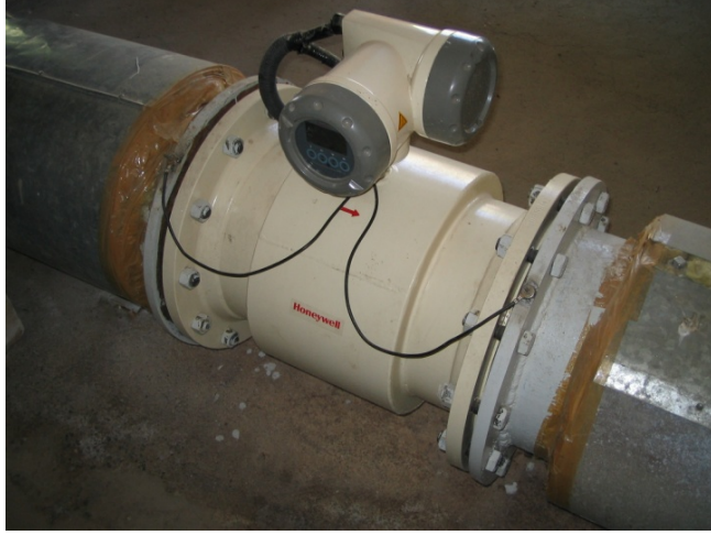
Şekil 2.9 Toplam debinin ölçüldüğü hat üzerine monte edilmiş manyetik debimetrenin görünüşü.
