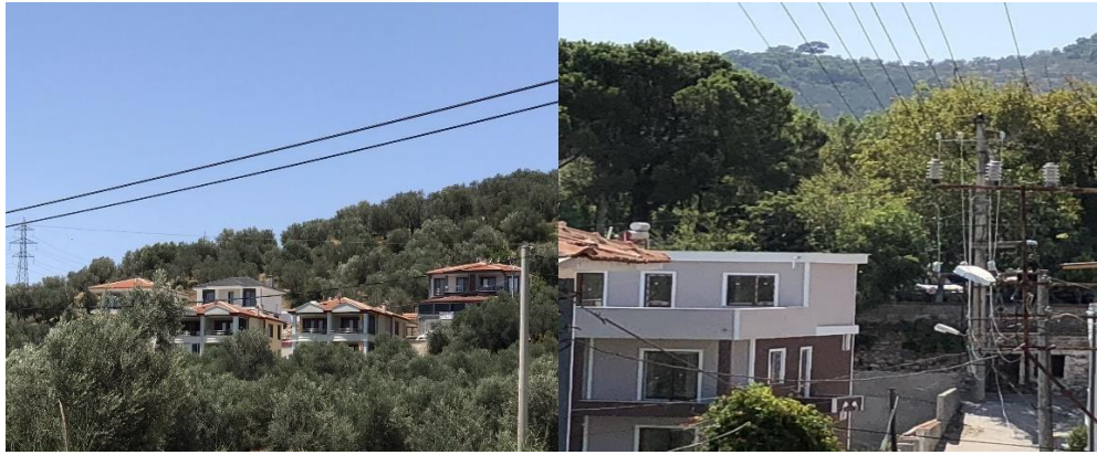
Foto 9 Güre’de Yer Alan Bazı Emekli Göçmen Konutları
