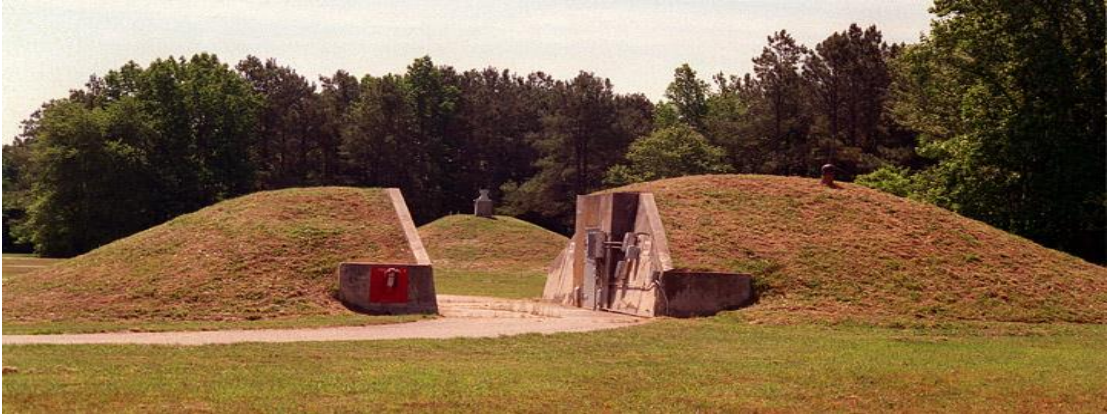
Şekil 3.3: İglo tipi standart olmayan toprak örtülü cephanelik
