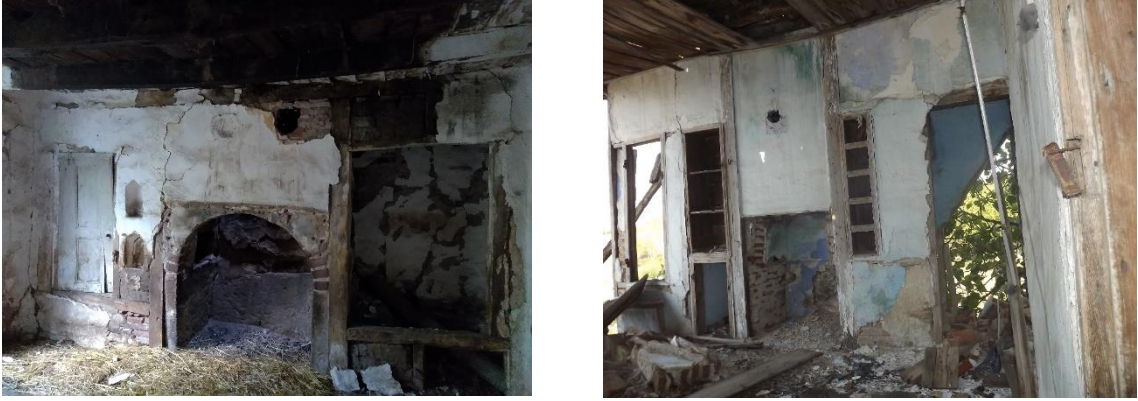
Şekil 4.71: Duvar nişleri, solda Yenikavak mahallesi / Balya, sağda Cumhuriyet mahallesi / Manyas.
