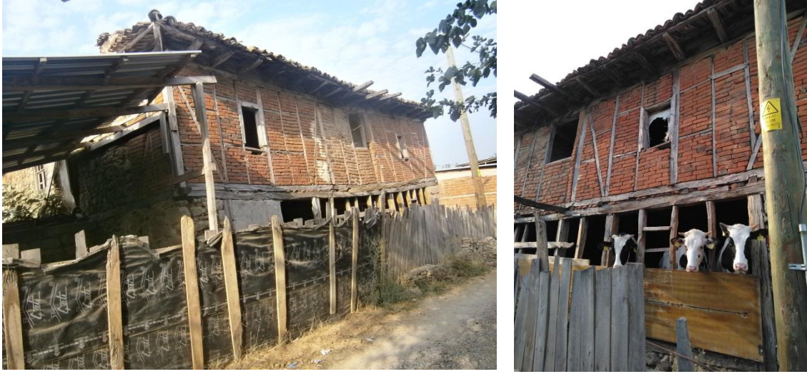
Şekil 4.40: Üstü konut altı dam (ahır) örneği, Yenikavak mahallesi.
