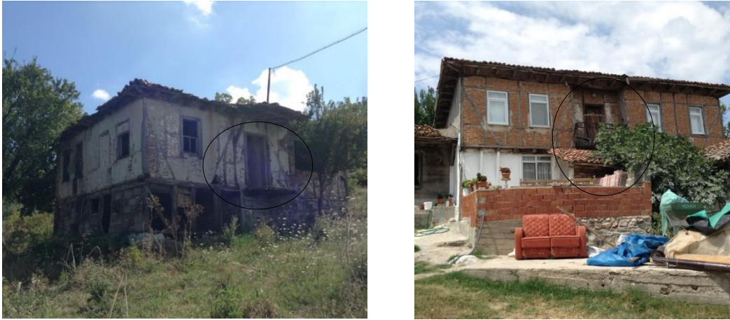
Şekil 4.59: Balkonlu yapı örneği, solda Çiftliklan mahallesi/ Gönen , sağda Günaydın mahallesi/ Susurluk.
