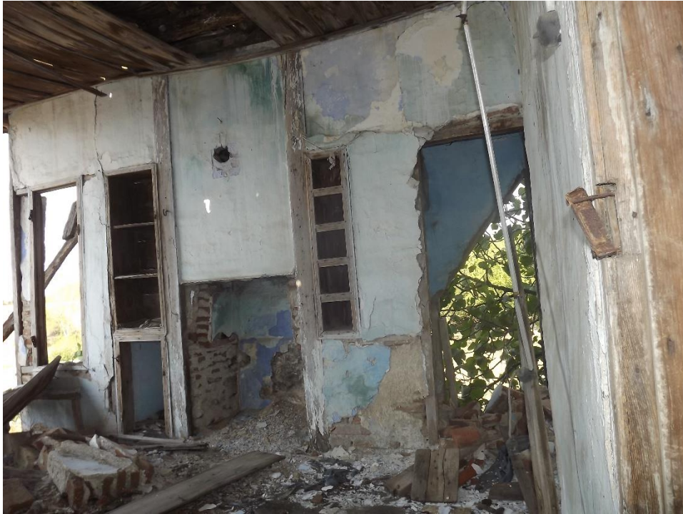
Şekil 5.125: Duvardaki niş, ocak ve bölmeler.
