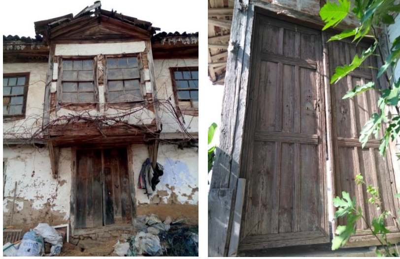
Şekil 4.49: İki kanatlı giriş kapısı, solda Mehmet Eryılmaz evi (Armutalan mahallesi / Karesi); sağda Feridun Çakmak evi (Cumhuriyet mahallesi / Manyas).
