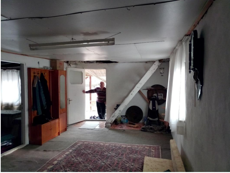
Şekil 5.85: Giriş sofasından görünüm.
