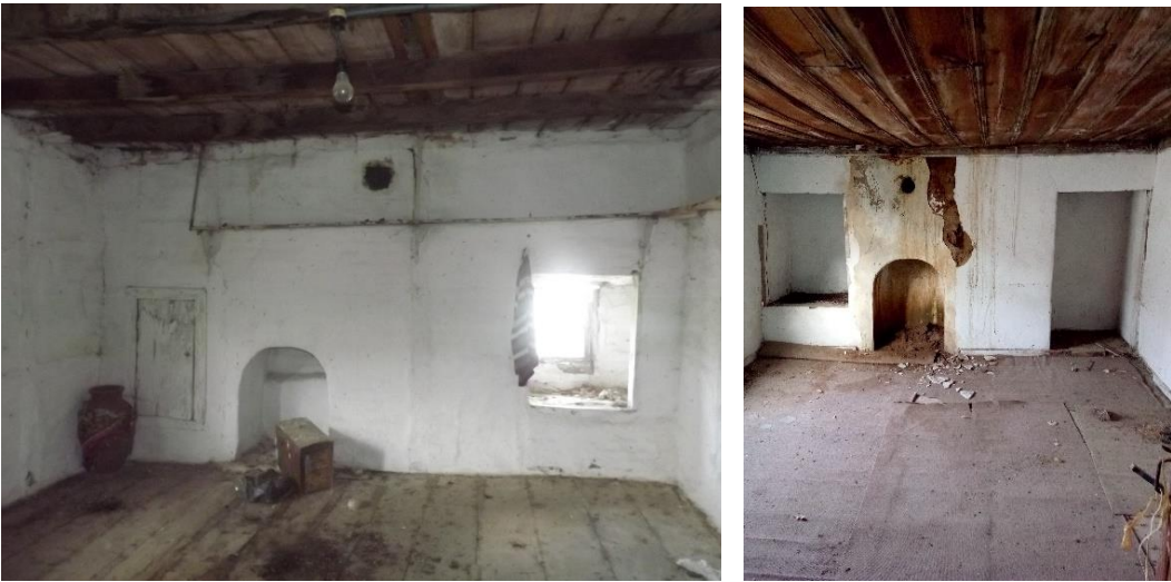
Şekil 4.30: Solda Ramazan Varol evi, sağda Ahmet Ayaz evi, Armutalan mahallesi.
