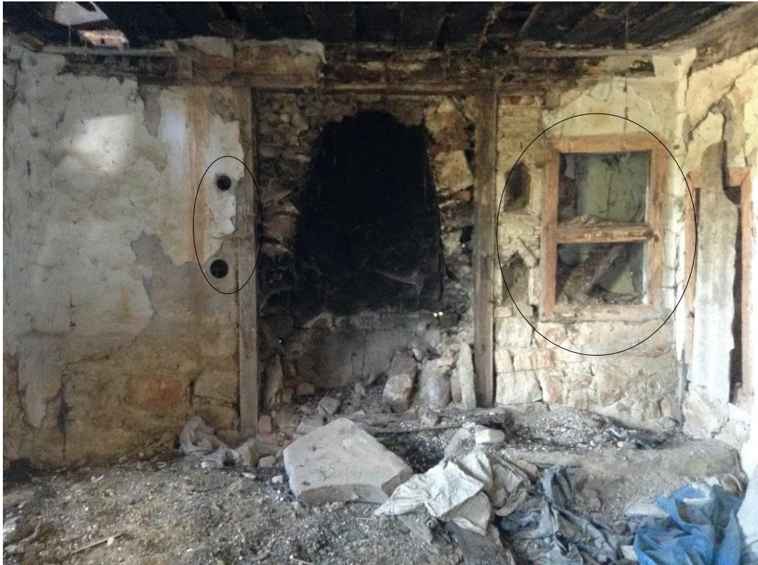
Şekil 4.72: Keseler, duvar nişleri, Çiftlikalan mahallesi / Gönen.
