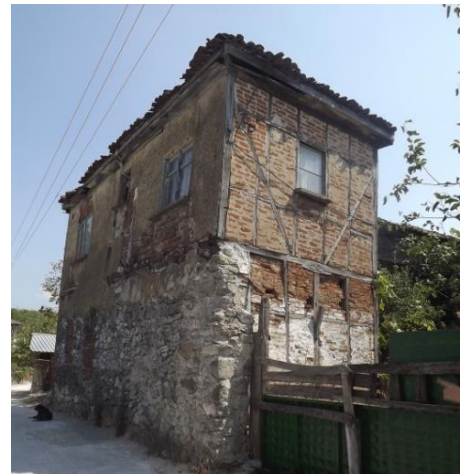
Şekil 4.1: Cumhuriyet mahallesi (Manyas) ahşap karkas arası tuğla malzeme kullanımı örnekleri.
