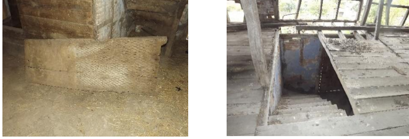
Şekil 4.67: Zemin döşemesi Ahmet Avcı evi, Pehlivanhoca mahallesi / Gönen.
