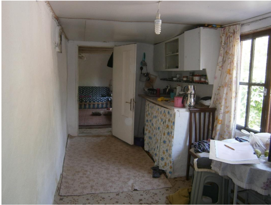
Şekil 5.15: Zemin kat giriş holü.
