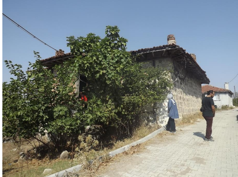
Şekil 5.115: Güney görünüşü (sokak cephesi).
