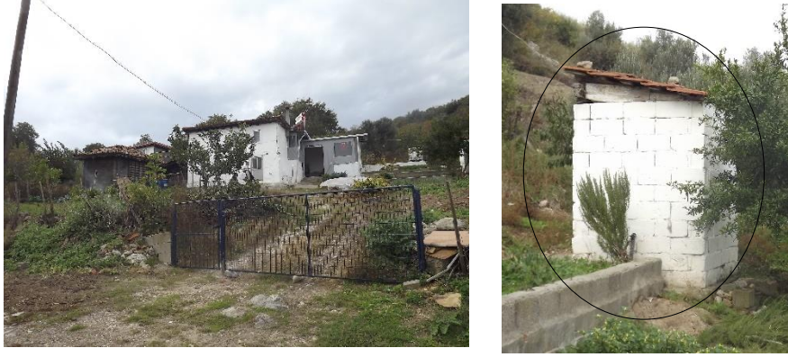
Şekil 4.38: Hela örneği, Coşkun Dede evi, Pehlivanhoca mahallesi/ Gönen.
