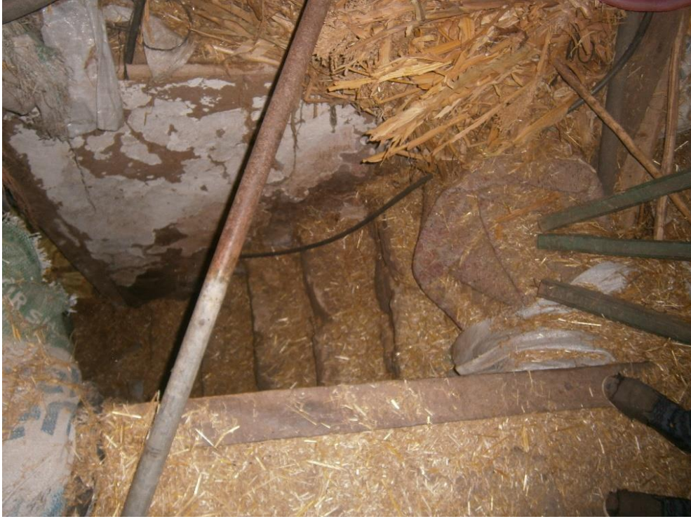
Şekil 5.47: Konut içerisindeki merdiven.
