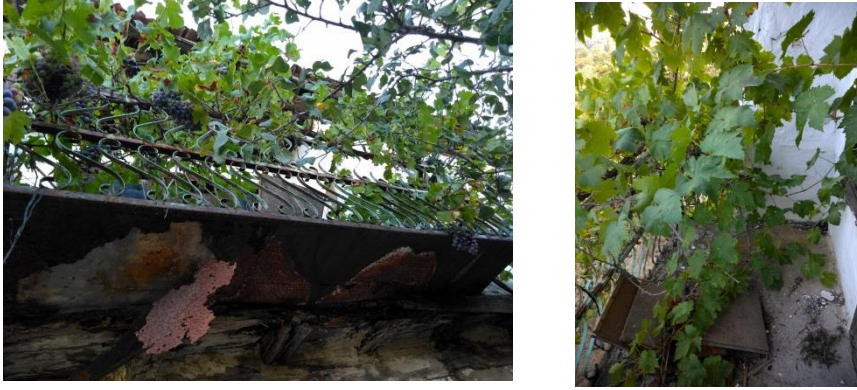
Şekil 4.58: Balkon detayı, Nuri Temel evi, Ekşidere mahallesi / Gönen.
