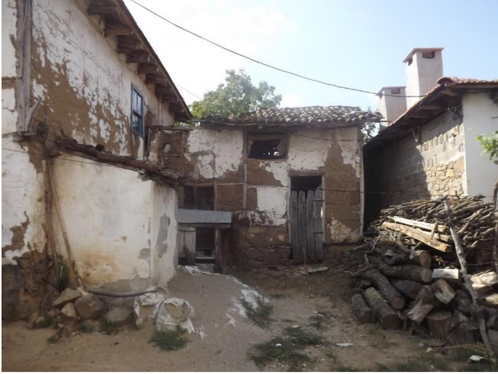
Şekil 5.26: Yapıya ek samanlık ve tuvalet yapısı.
