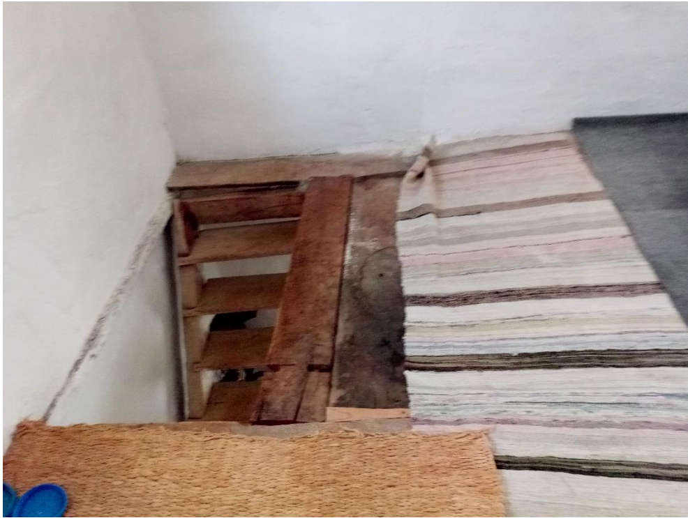
Şekil 5.88: Merdivenden sofaya geçiş.
