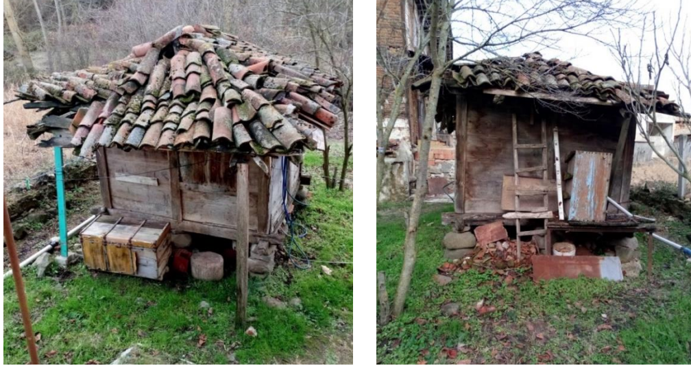
Şekil 4.12: Ambar (beğeli) örneği, Mehmet Gürhan evi (Armutalan mahallesi).
