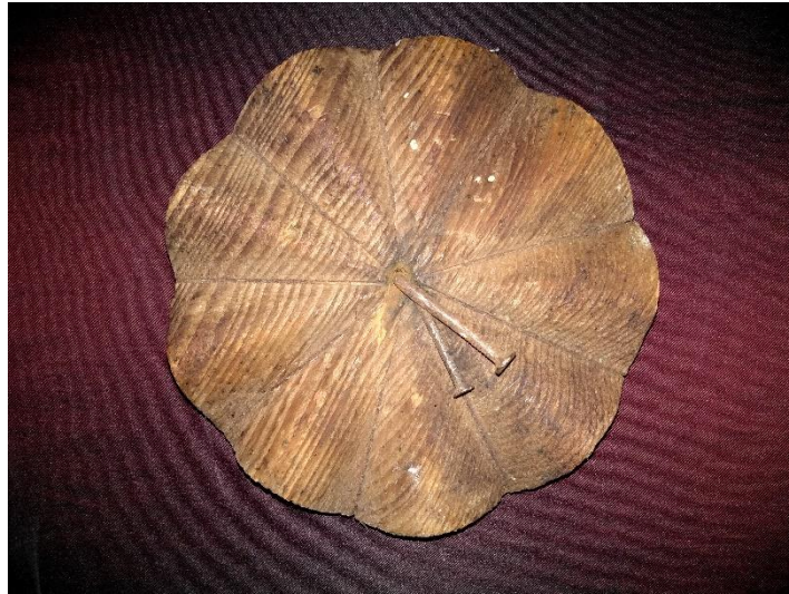
Şekil 4.66: Tavan göbeği, Osman Yazıcı evi, Pehlivanhoca mahallesi / Gönen.
