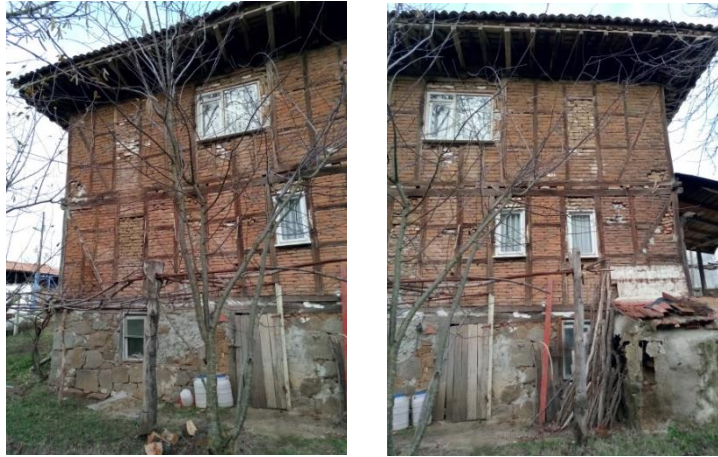
Şekil 4.56: Kapatılan pencere boşluğu izleri ve yenilenen pencereler, Mehmet Gürhan evi, Armutalan mahalesi / Karesi.
