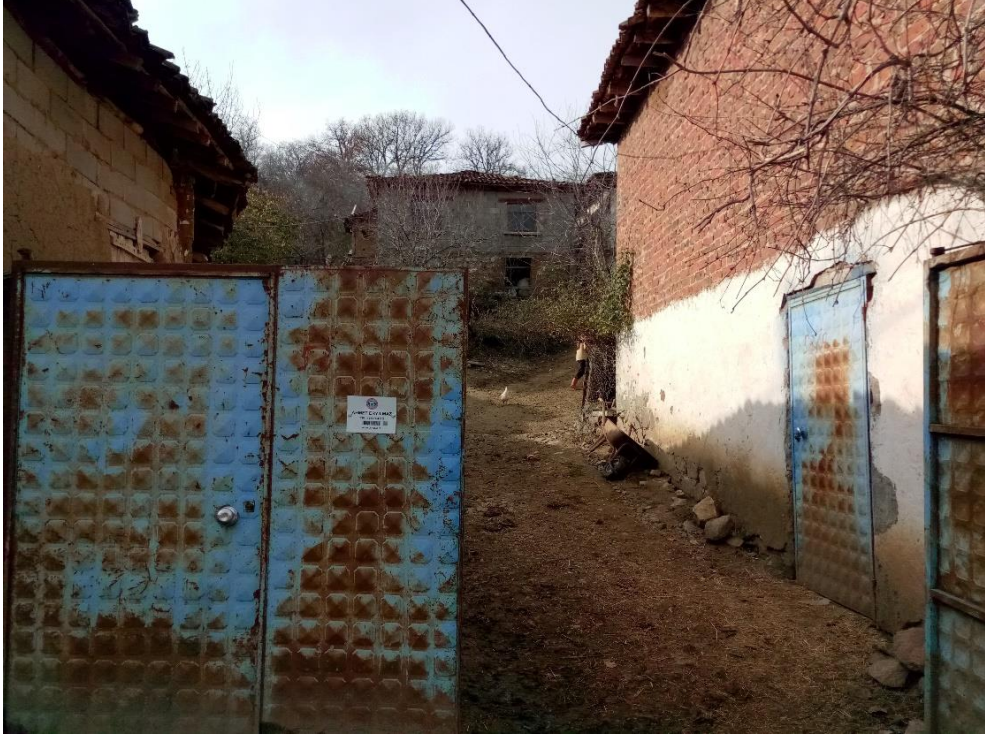
Şekil 5.36: Avluya giriş kapısı.
