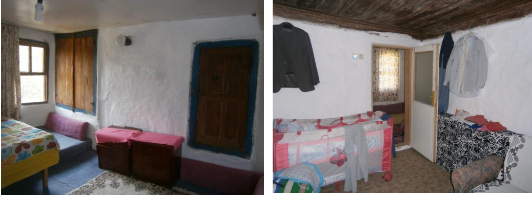
Şekil 4.31: Oda (sekvi, yüklük, gusülhane), Şaban Türkoęlu evi, Armutalan mahallesi.
