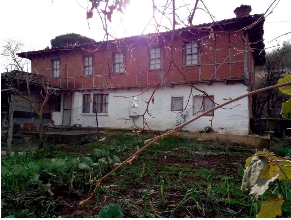
Şekil 5.7: Kuzeybatı cephesi giriş cephesi.
