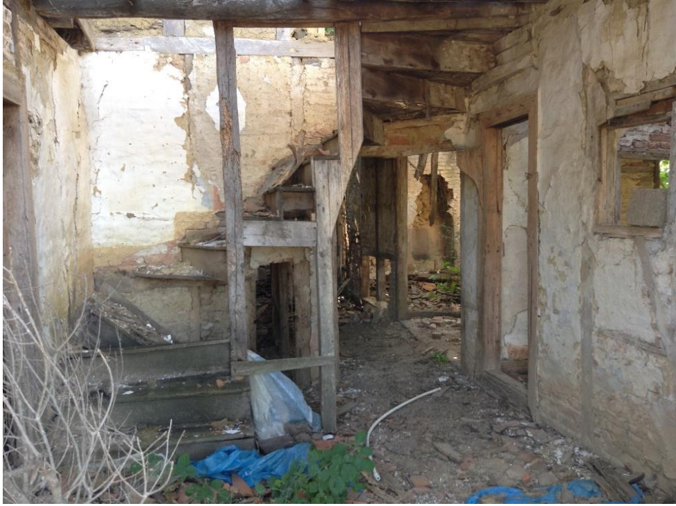
Şekil 4.64: Merdiven örneđi, Çiftlikalan mahallesi / Gönen.
