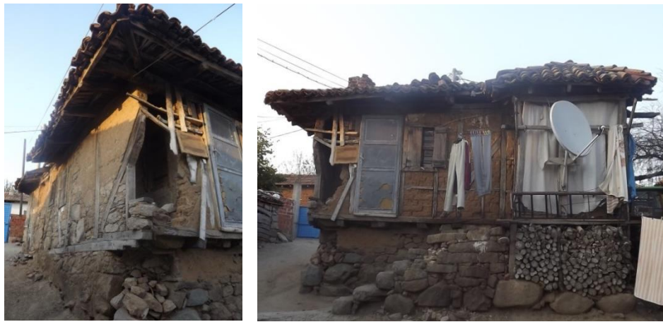
Şekil 4.2: Yenikavak mahallesi (Balya) ahşap karkas arası kerpiç malzeme kullanımı örneği.
