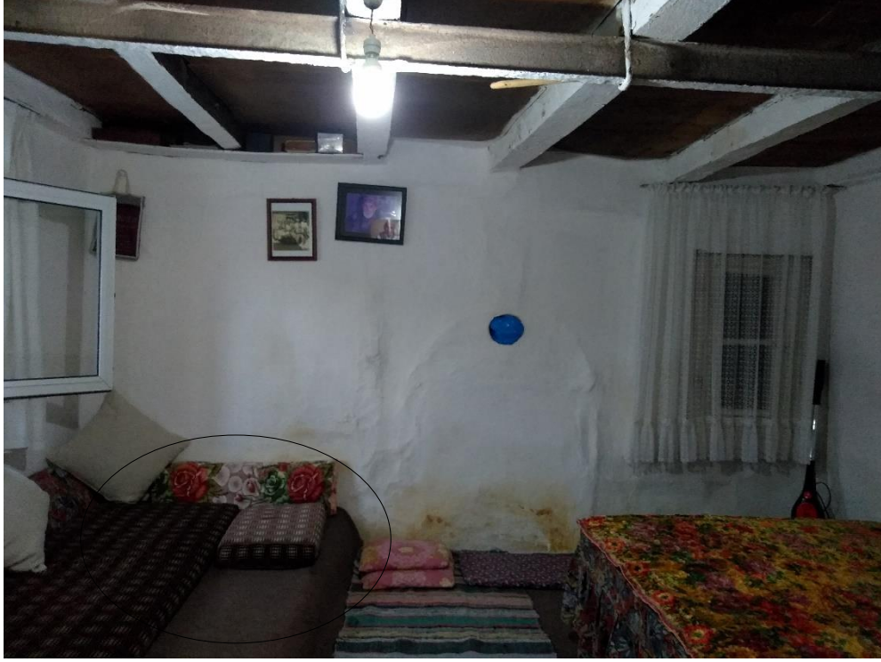
Şekil 4.75: Sekvi, Osman yazıcı evi, Pehlivanhoca mahallesi / Gönen.
