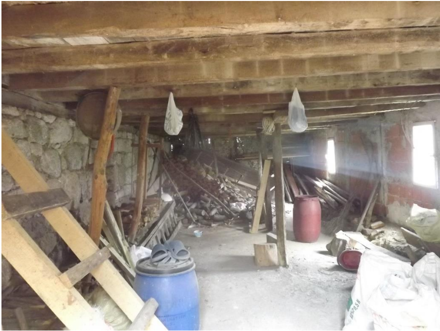
Şekil 5.153: Ahır (dam) / depo.
