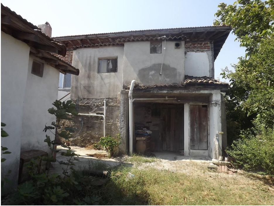
Şekil 5.136: Ahıra (dama) ve depoya giriş kapıları.
