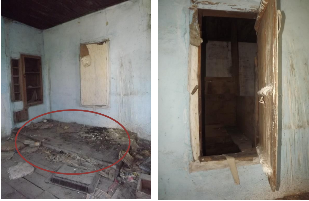
Şekil 5.126: Sekvi ve ambar kapağı.
