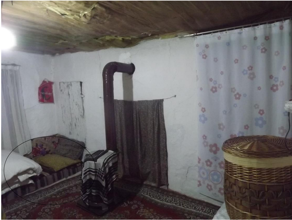
Şekil 4.76: Sekvi, Halit Çil evi, Balcıdede mahallesi / Gönen.
