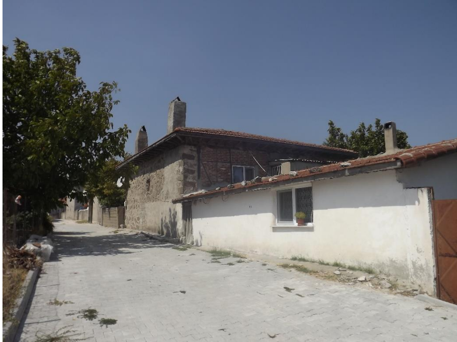
Şekil 5.132: Yaşar Çakmak evinin sokaktan görünüşü.
