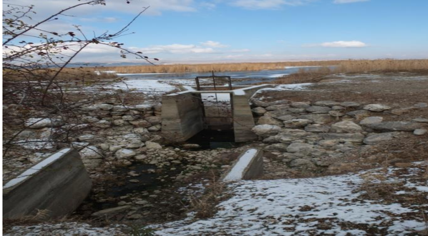
Şekil 6. Gölün Güneyinde Düden ve Regülâtör.
