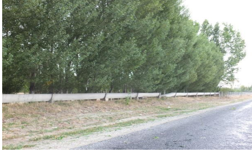
Şekil 38. Karamık Köyü'nde Alanı Drene Eden Su Kanalı.
