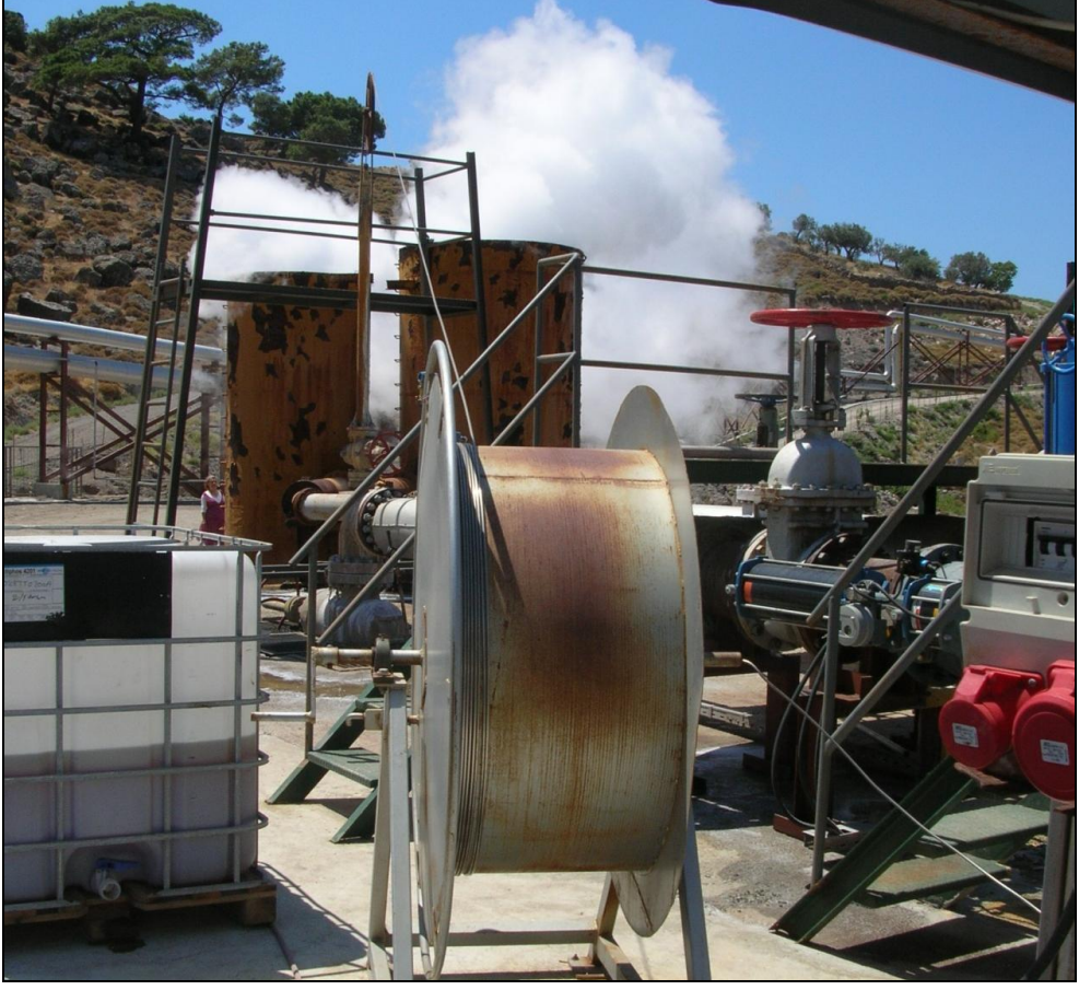
Şekil 4.3 Üretim kuyularındaki inhibitör sisteminden bir görünüm (Tuzla)
