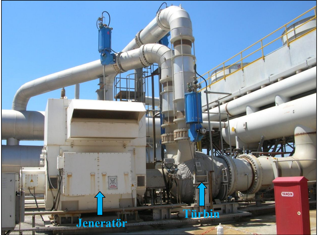
Şekil 4.6 Birleşik türbin ve jeneratör sistemi (Tuzla)
