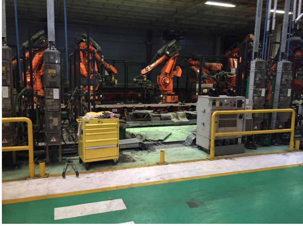
Resim 5.6: Mekanik ve elektrik hatların hazırlanması.
