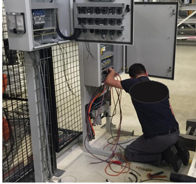
Resim 5.17: Operatör Panelinin kurulumu.
