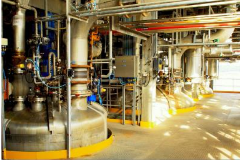
Şekil 4.8: Bir UF/MF reine tesisindeki reaktörlerin üst (besleme) kısımlarının görünüşü.
