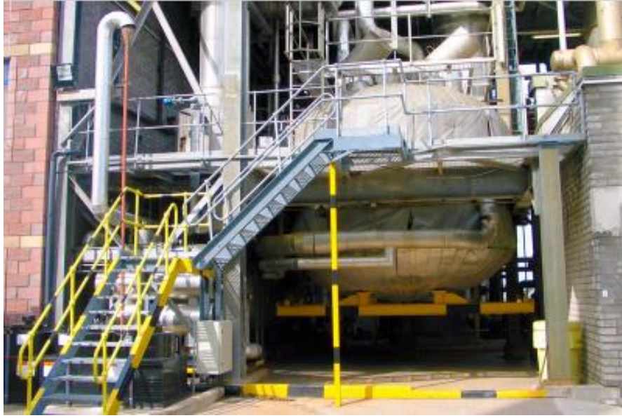
Şekil 4.9: Bir Formaldehit reaktörü ve metanol besleme kısmı.
