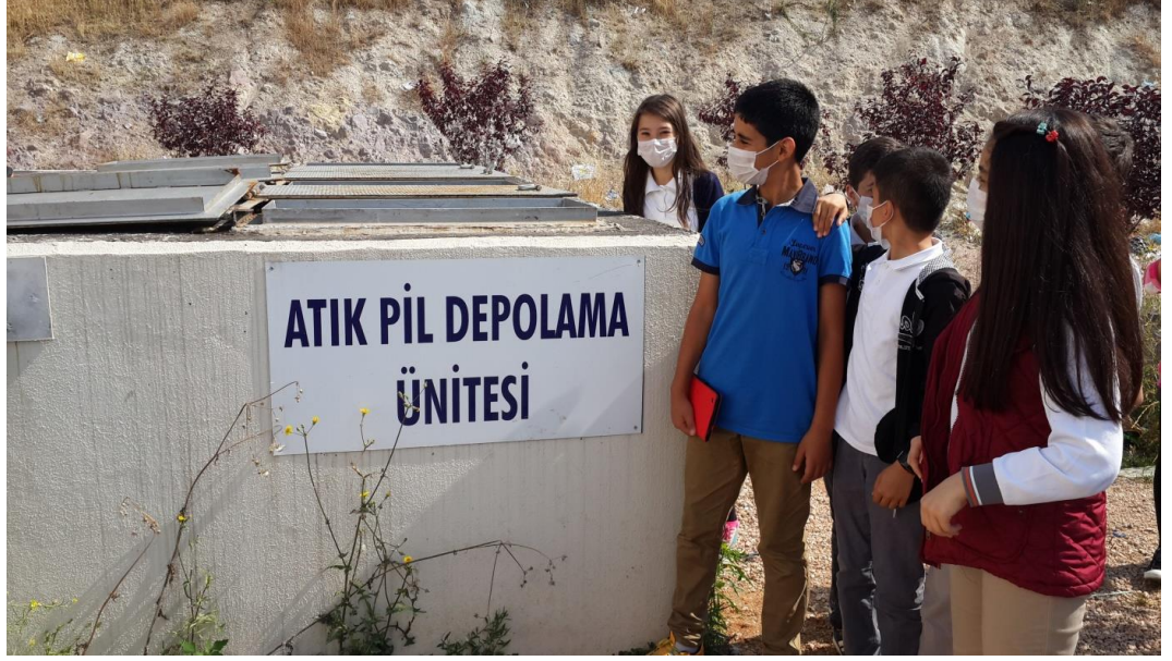
Foto 16. Katı Atık Depolama Tesisinde Yer Alan Atık Pil Toplama Kuyuları
