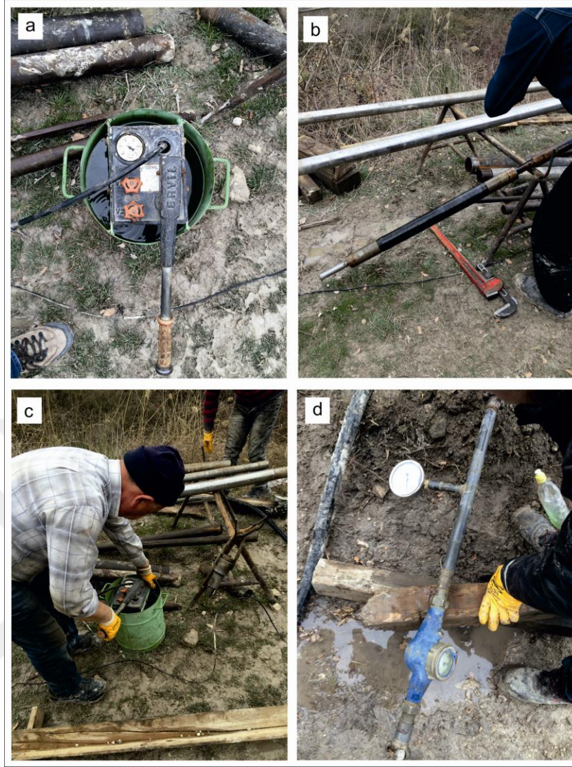
Şekil 2.11: Çağış gölet alanında yapılan basınçlı su deneyi çalışmaları (a-d).
