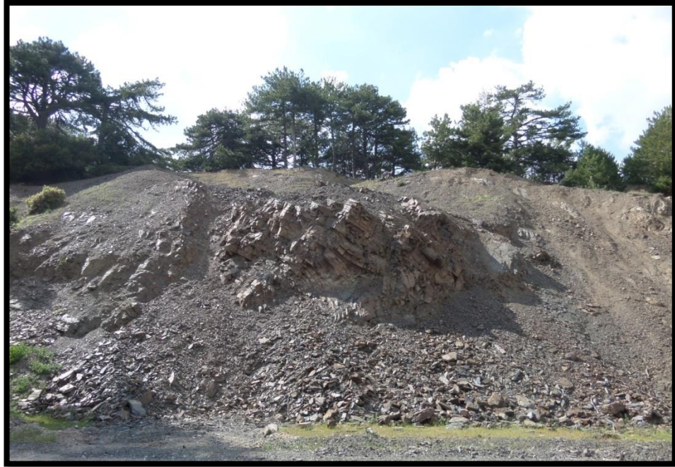
Şekil 21. Sancaklı Uzunçınar - Ayvacık Arasında Deformasyona Uğramış Fliş Tabakaları
