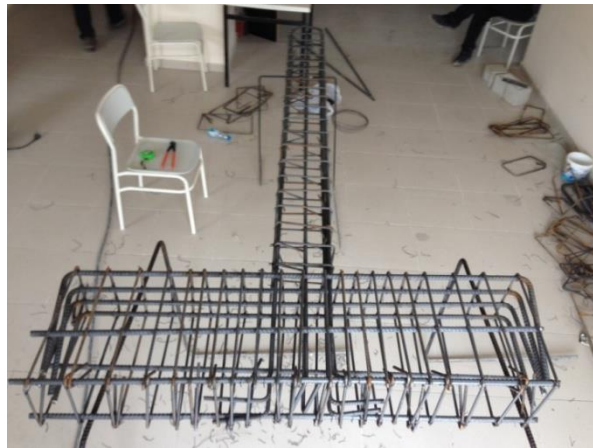
řekil 3.2: Donatıların hazırlanması
