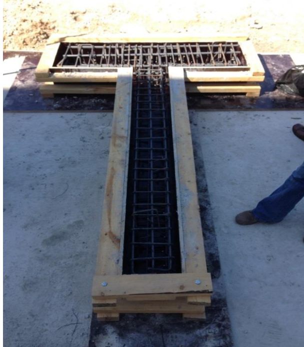
Şekil 3.3: Donatıların kalıba yerleştirilmesi
