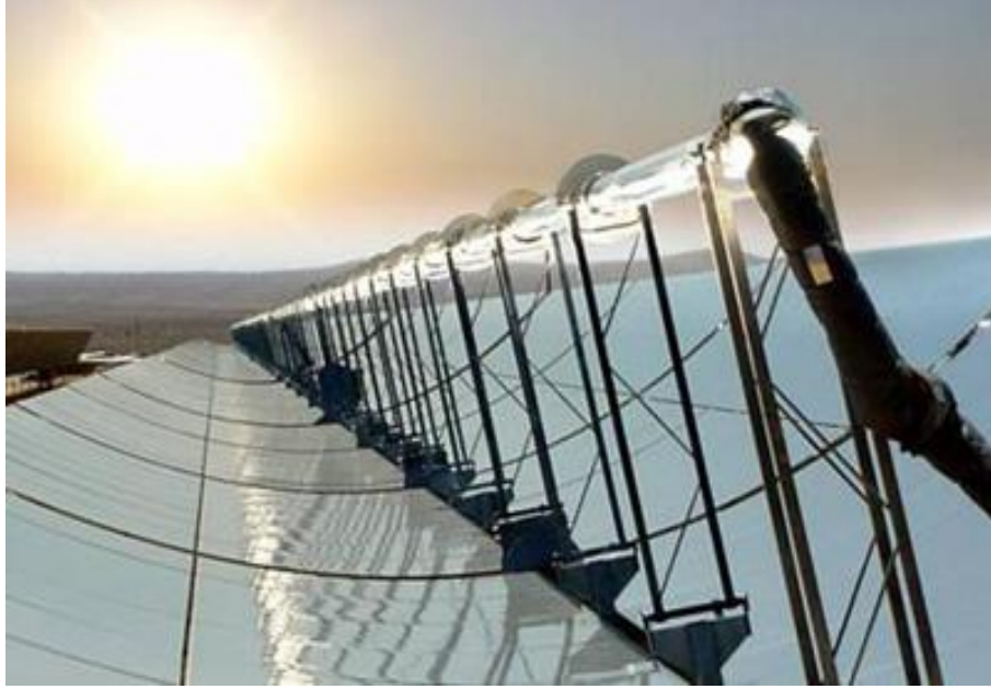
Şekil 1.11: Parabolik güneş toplayıcıları [24]
