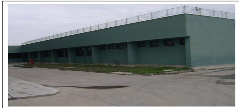
Şekil 2.2: Balıkesir üniversitesi rektörlük matbaa binası (ek bina) resmi
