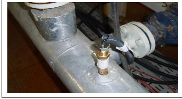
Şekil 2.12: Su sıcaklık ölçümü için sıcaklık sensörü Pt-100 montajı
