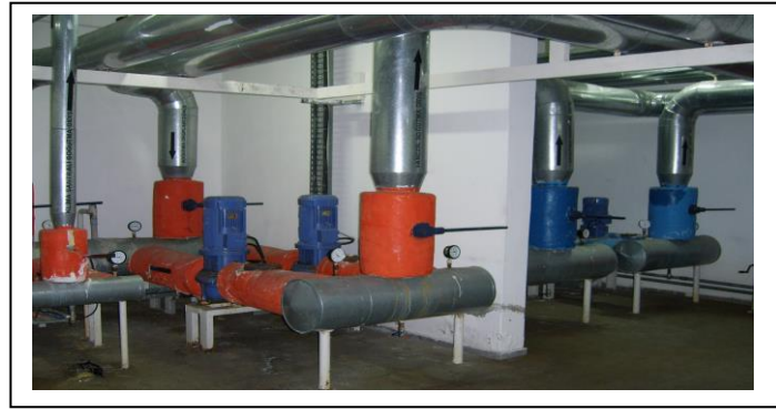
Şekil 2.35: Soğutma sistemi sirkülasyon (santrifüj) pompalarının görünümü
