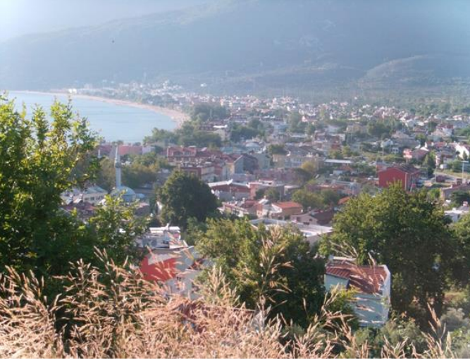
Foto 32: Erdek ilçe merkezi çalışma sahasının en gelişmiş iskan sahalarına ve toplu yerleşim dokusuna sahip bir kıyı yerleşmesidir.
