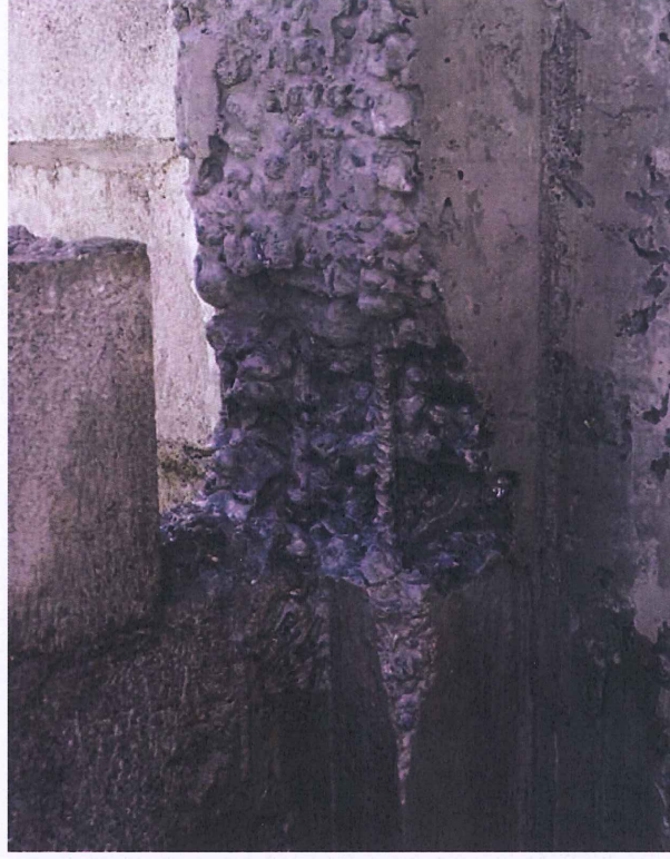
Şekil 3.8: Kolon alt ucunda sıkıştırma yetersizliği
