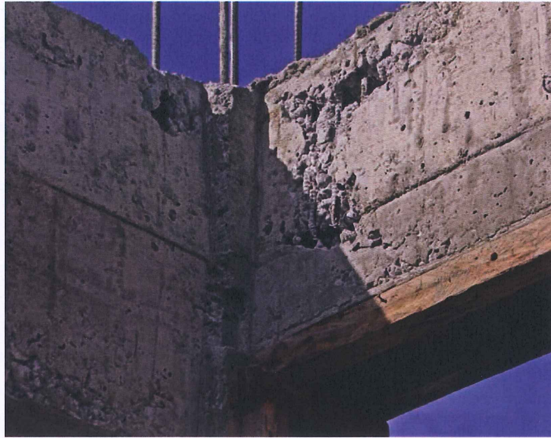
Şekil 3.7: Düğüm noktasında sıkıştırma yetersizliği
