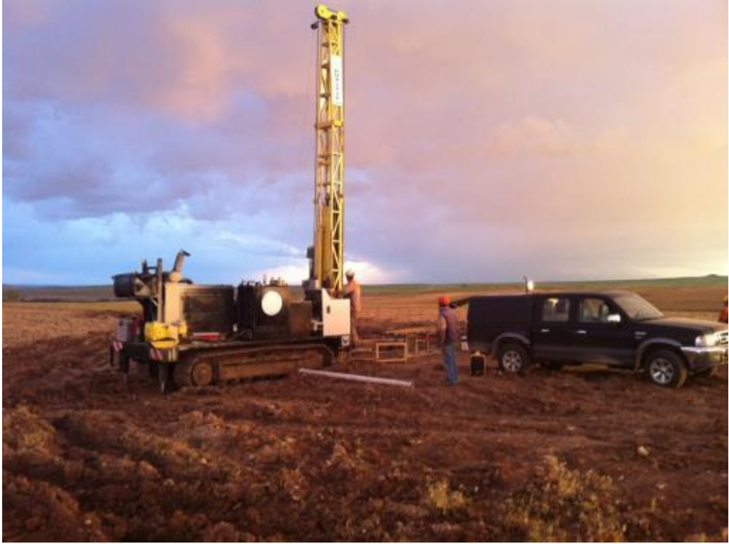
Şekil 1.3: Sondaj çalışması ile karot alımından bir görünüm.
