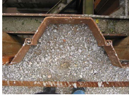
Şekil 3.16: En yaygın kullanılan çelik palplanş kesitleri
