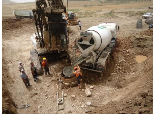
Şekil 3.19: Fore kazık uygulamaları
