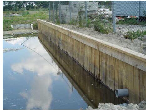
Şekil 3.14: Ahşap palplanş perde
