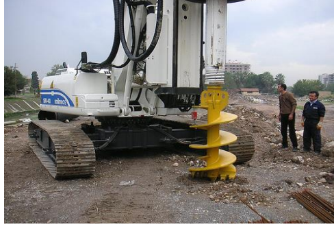
Şekil 3.18: Fore kazık makinası
