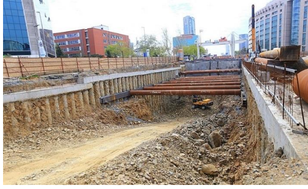
Şekil 3.10: Aç-kapa yöntemiyle yapılan bir kazı
