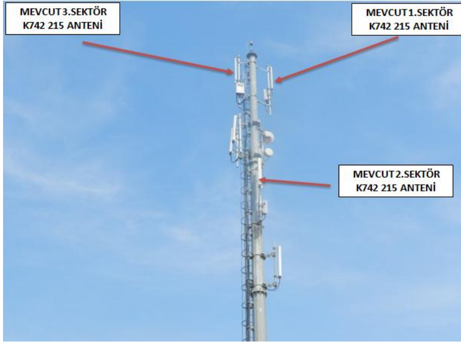
Şekil 4.10: Balıkesir toki baz istasyonu antenleri
