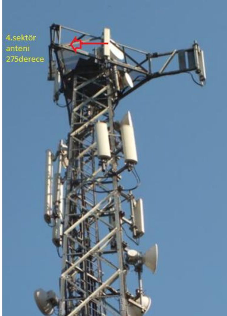
Şekil 4.7: Mevcut baz istasyonu revizyonu uygulanan 4.sektör anteni
