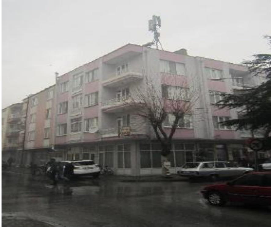
Şekil 4.14: Balıkesir doğumevi Baz istasyonu antenleri
