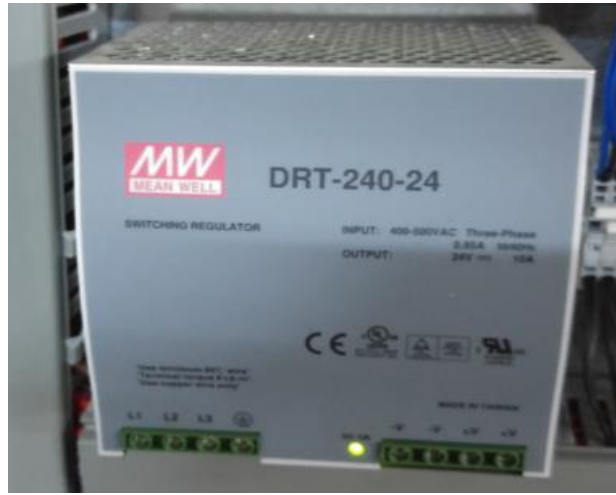
Şekil A.4: PLC güç besleme ünitesi
