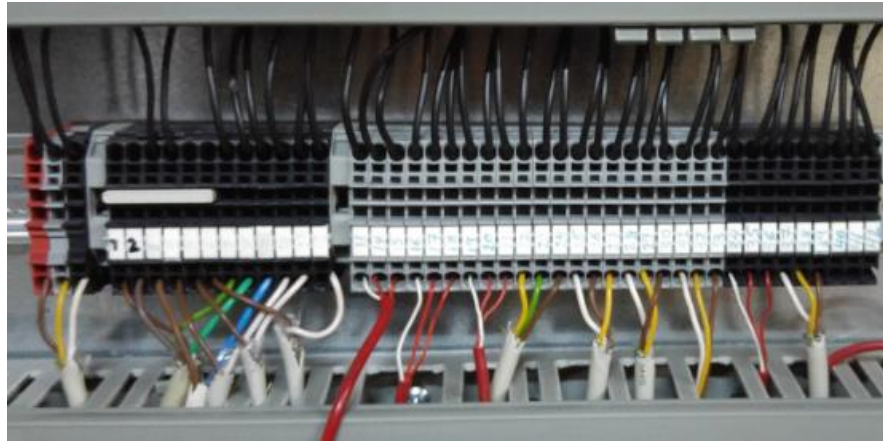
Şekil A.11: Sıcaklık, basınç ve sensör klemensleri
