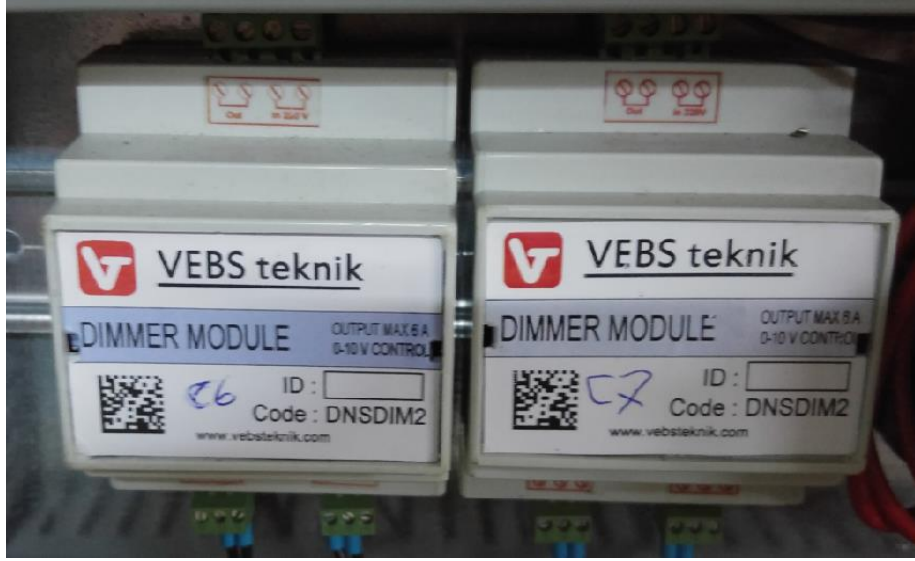
Şekil A.6: Kondenser ve evaporatör dimmer modülleri
