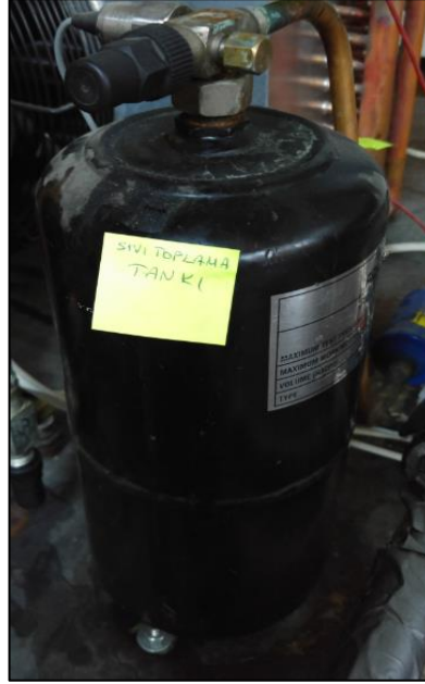
Şekil 5.9: Sıvı toplama tankı
