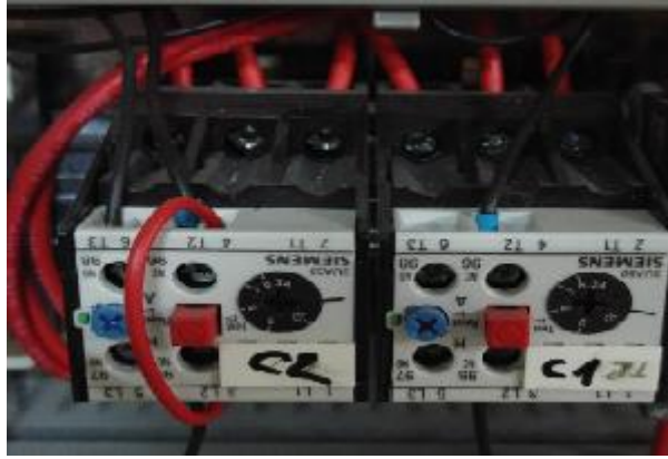
Şekil A.7: Ana kontaktör ve frekans sürücü termikleri
