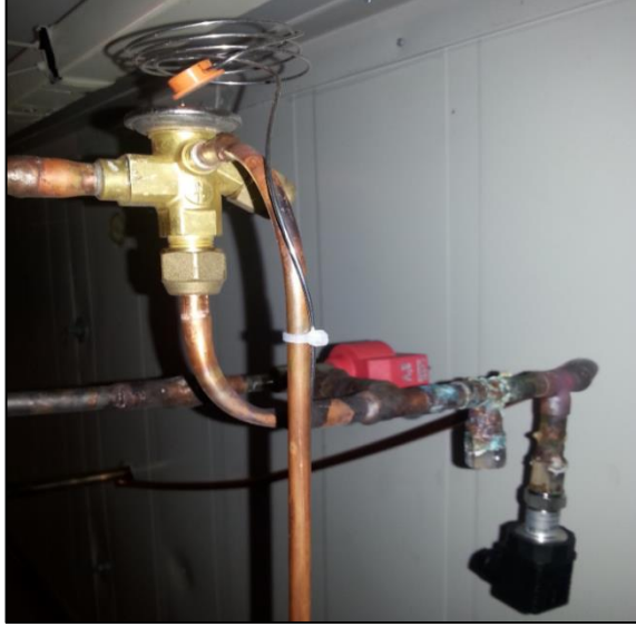
Şekil 5.8: Termostatik ve elektronik genleşme valfleri
