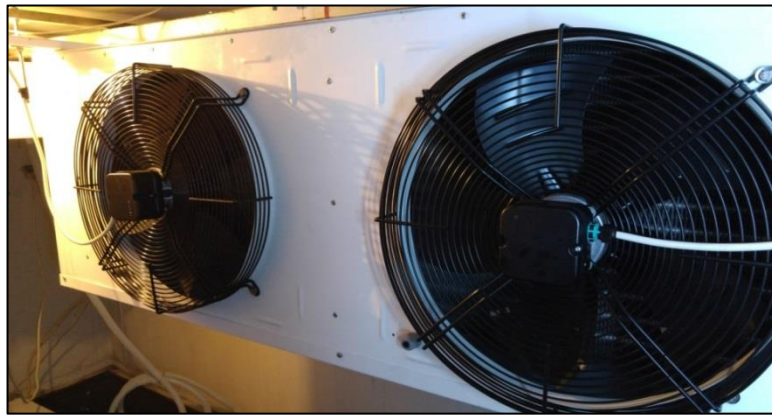
Şekil 5.5: İki fanlı evaporatör
