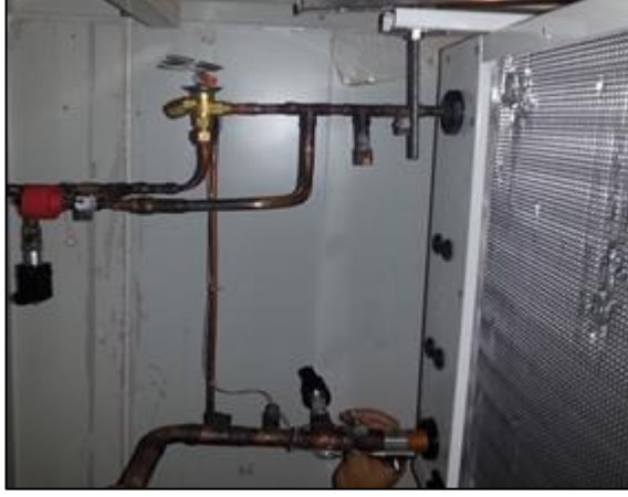
Şekil 5.6: Evaporatör ve genişleme valfleri
