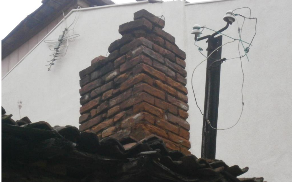
Şekil 3.17: Ani ısı değişimi sonuca baca tuğlalarında görülen bozulma [10]
