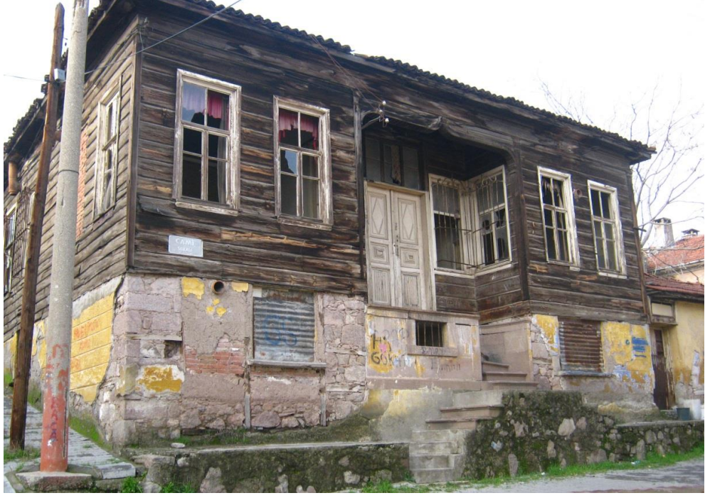
Şekil 5.8: Eğimli arazide bodrum katta taşıyıcı olan yığma taş [10]
