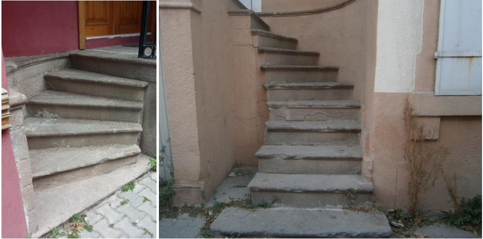
Şekil 6.10: Taş merdiven basamaklarında sürtünmeden dolayı aşınma [10]
