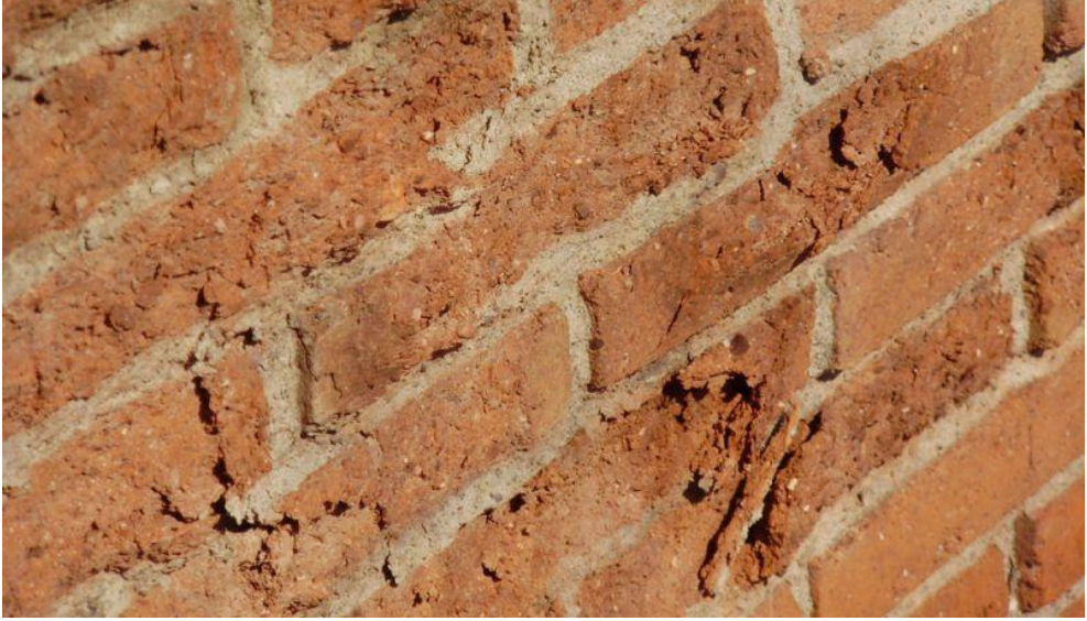
Şekil 3.19: Tuğlada kavlanma [54]
