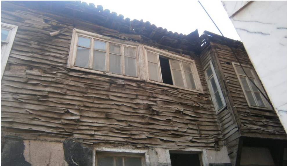
Şekil 3.32: Ahşapta doku bozulması [10]
