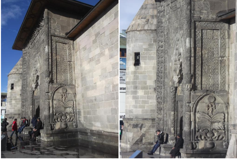
Şekil 3.11: Taş yüzeyinde kirlilik [7]
