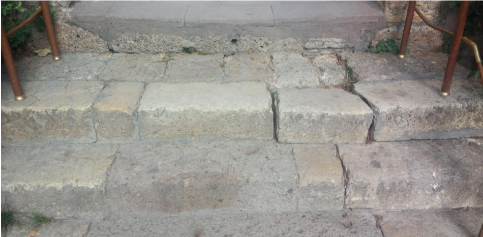
Şekil 3.4: Eşik taşındaki aşınma [10]
