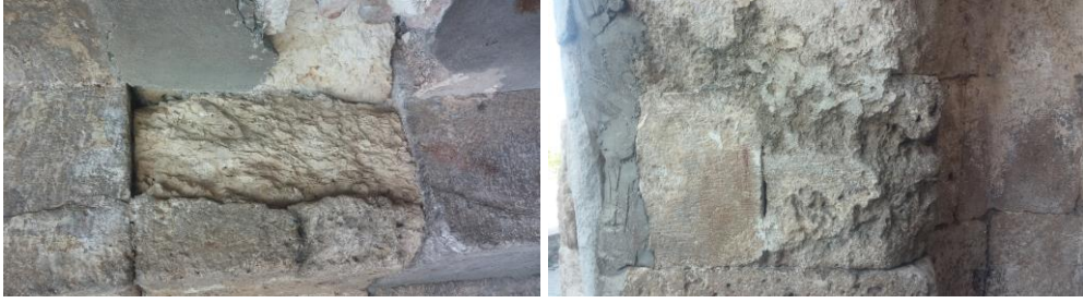
Şekil 3.3: Taşın yapısından kaynaklanan bozulmalar [10]
