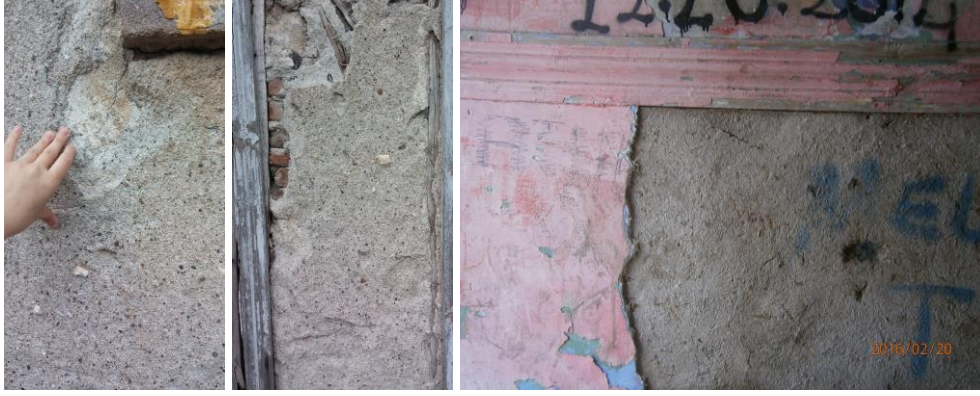
Şekil 6.29: Sıva harcında ufalanma [10]
