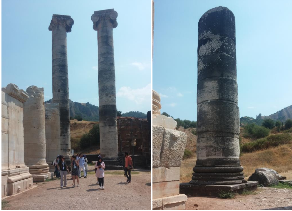
Şekil 3.10: Taş yüzeyinde kabuk oluşumu [10]
