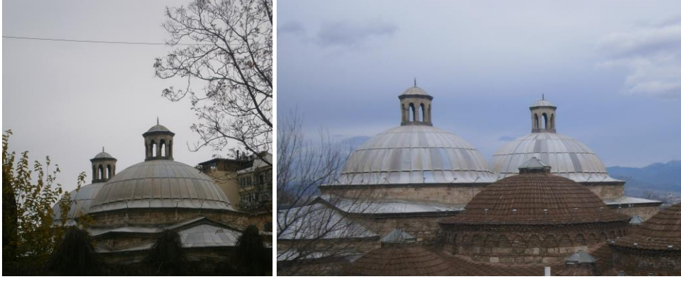
Şekil 2.7: Tarihi yapılarda çatı kaplaması olarak metal kullanımı [10]
