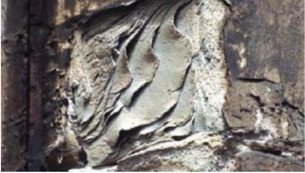
Şekil 3.8 : Taş malzemede yapraklanma [45]
