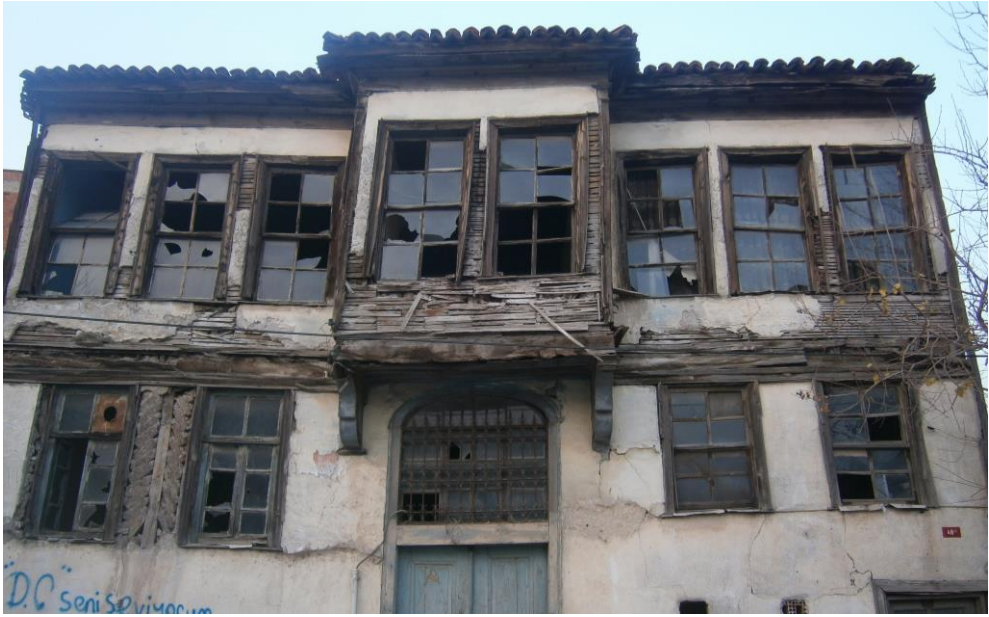
Şekil 5.13: Karkas sistemde dolgu elemanı olarak kerpiç [10]
