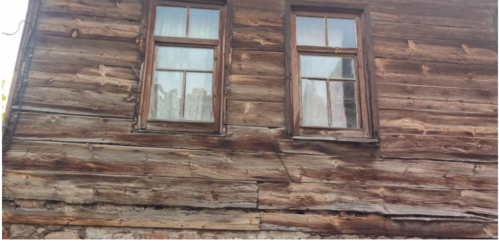
Şekil 3.31: Ahşap kaplamada renk deęişimi [10]
