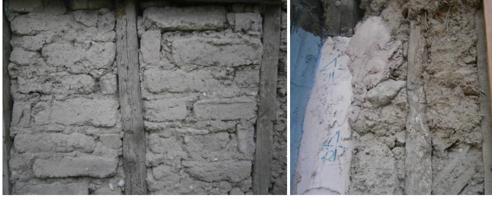
Şekil 3.37: Kerpiç malzeme ufalanma [10]
