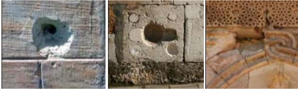
Şekil 3.14: Taşta çeşitli sebeplerden oluşmuş boşluk ve delikler [47]
