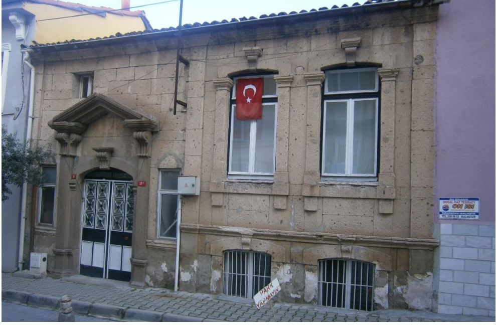
Şekil 5.10: Düz zeminlerde taş yığma yapım sistemi [10]
