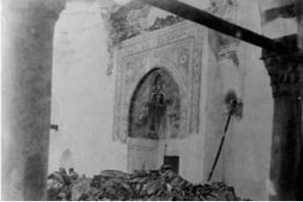
Şekil 2.8: 1898 Balıkesir depreminde zarar gören Zağnos Paşa Cami [33]
