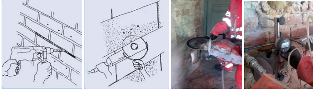
Şekil 3.54: Flat-jack uygulamasından önce tuğlalar arasındaki yuvaların hazırlanması [74]
