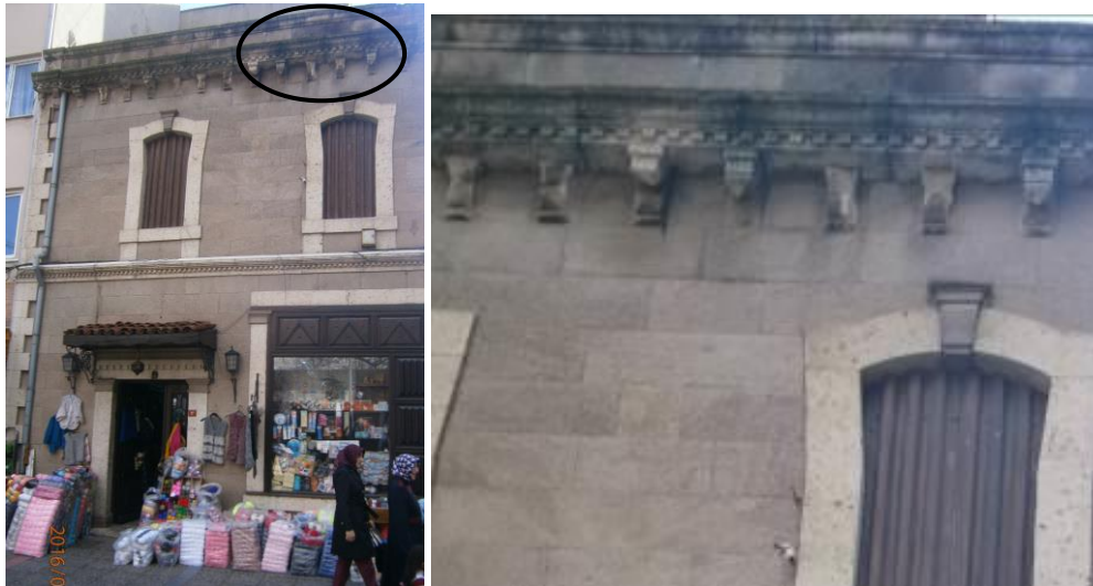
Şekil 6.3: Taş malzeme kabuk oluşumu [10]
