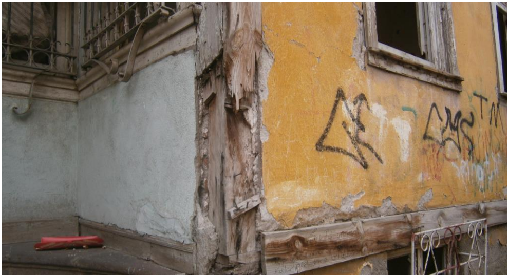
Şekil 6.22: Ahşapta böcek ve kurt etkisi ile parça kaybı [10]
