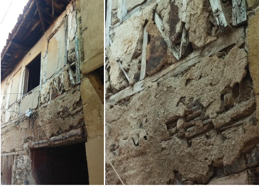
Şekil 3.44: Kerpiç duvar sıvasında ayrışma [10]
