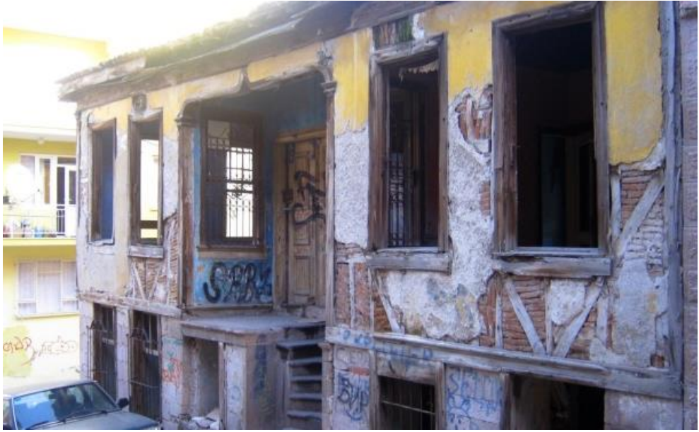
Şekil 5.11: Karkas sistemde dolgu elemanı olarak tuğla [10]
