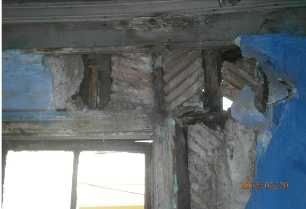
Şekil 6.26: Sıva harcının dökülmesi [10]
