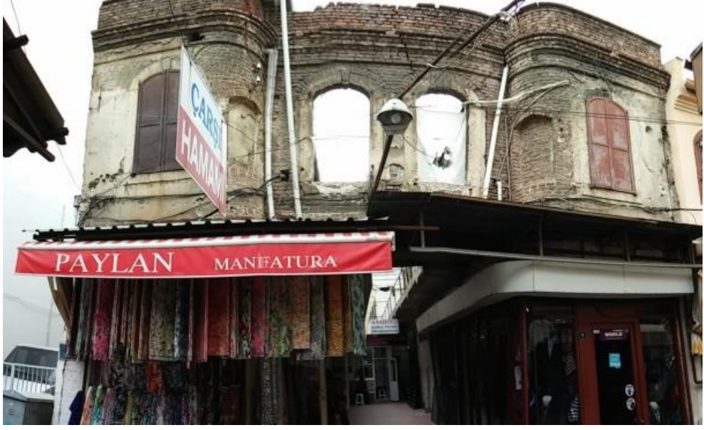
Şekil 5.12: Yığma tuğla yapım sistemi [10]
