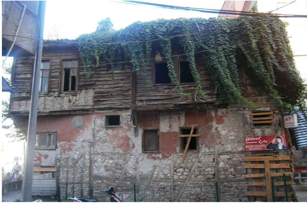
Şekil 5.9: Karkas sistemde dolgu elemanı olarak taş kullanımı [10]
