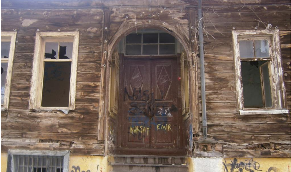
Şekil 6.17: Ahşap cephede renk değişimi [10]
