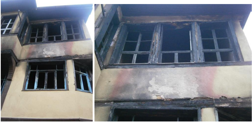
Şekil 3.36: Yangının ahşap yapı malzemesine etkisi [10]
