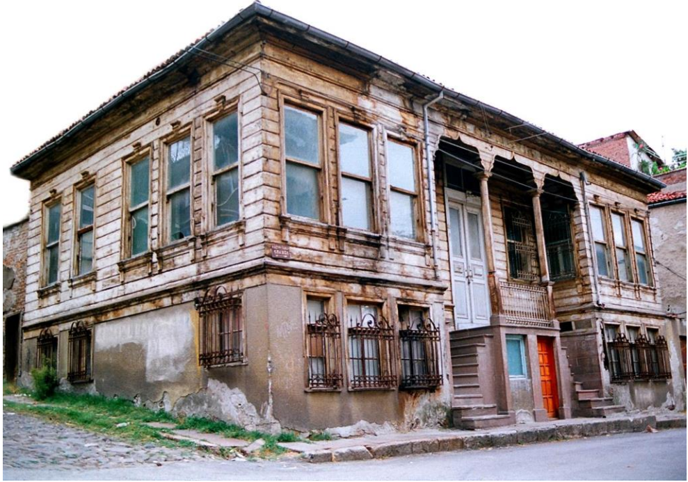
Őekil 5.7 : Cephe kaplaması olarak ahŐap [10]
