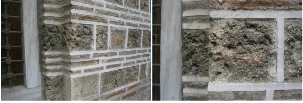
Şekil 3.5: Taşın yapısındaki taneli yapıların ayrılması sonucu oyuklanma [10]
