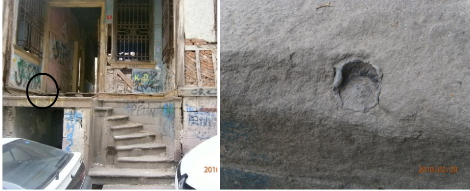
Şekil 6.6: Metalin aşınması sonucu taş malzemede oluşturduğu delik [10]
