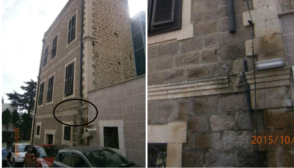
Şekil 6.2: Kat silmesinde görülen parça kopması [10]
