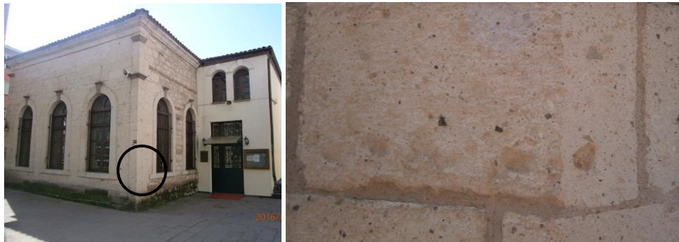
Şekil 6.1: Taş malzemede oyuklanma [10]
