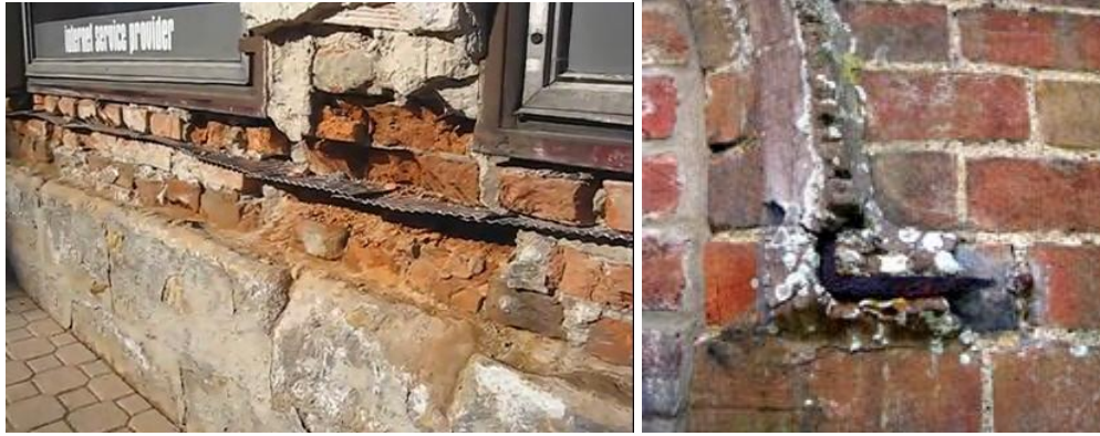
Şekil 3.25: Kötü detay kullanımından dolayı tuğlada bozulma [58]
