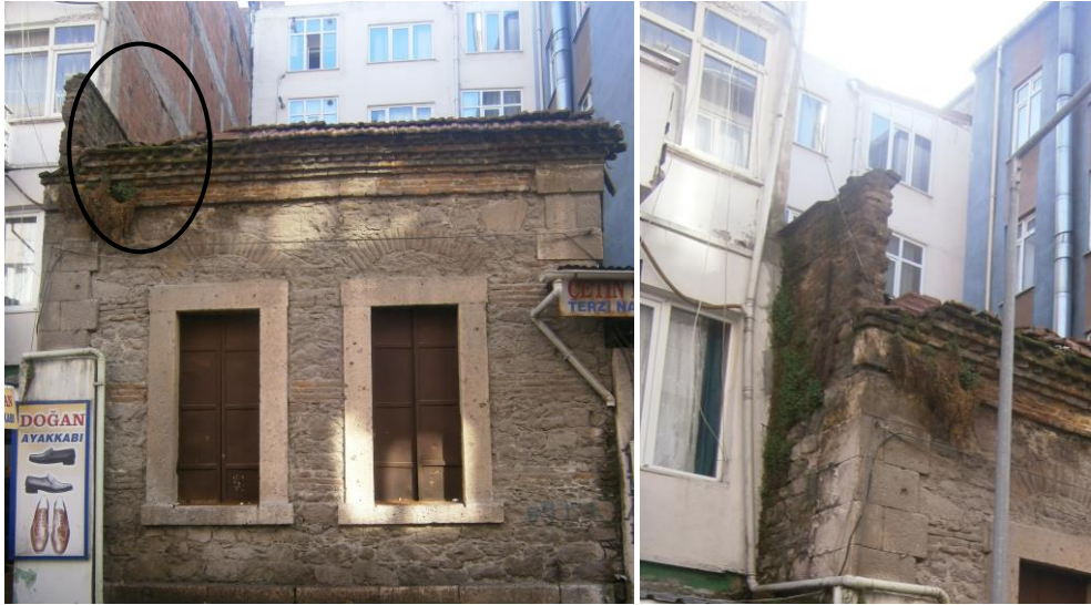
Şekil 6.5: Çatıda oluşan bitki ve biyolojik oluşumlar [10]
