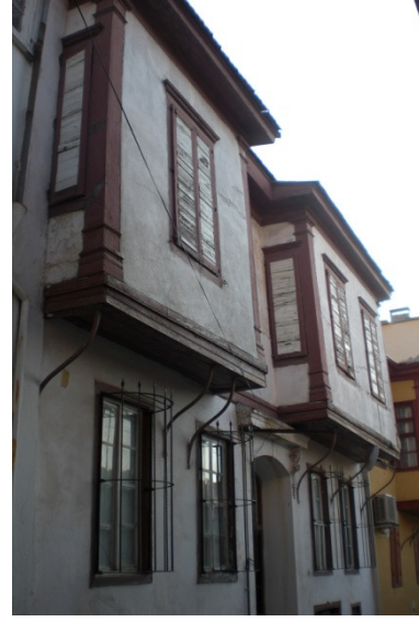
Şekil 4.4: İncelenen evlerden 9 nolu ev 2
