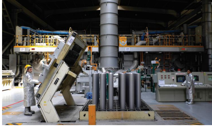
Şekil 5.4: Dökümhane üretim tesisi.
