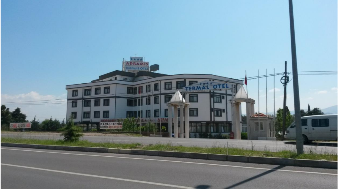
Fotoğraf 37: Şehrin Güneyindeki Adramis Termal Oteli
