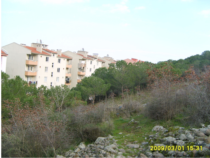
Şekil 8.3 2-B Arazilerinden Bir Görünüm
