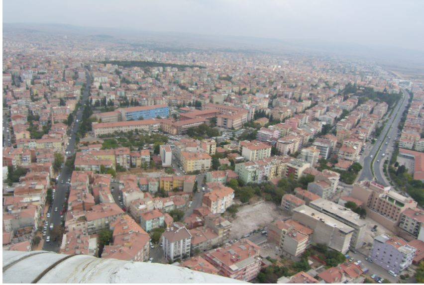
Şekil 7.12 Sık Yoğunluktaki Yerleşim Alanlarının Hava Fotoğrafı (Atatürk Mahallesi)
