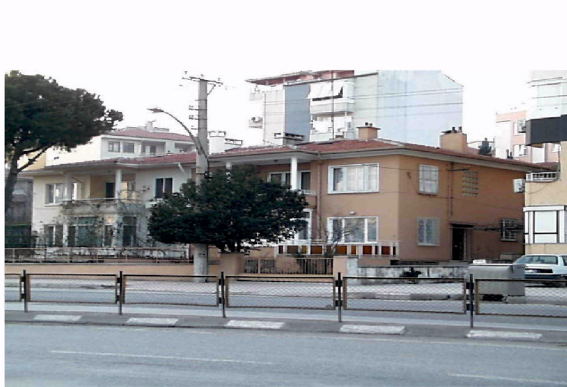
Şekil 6.33 İlk Toplu Konut Çalışmalarından 52 Evler
