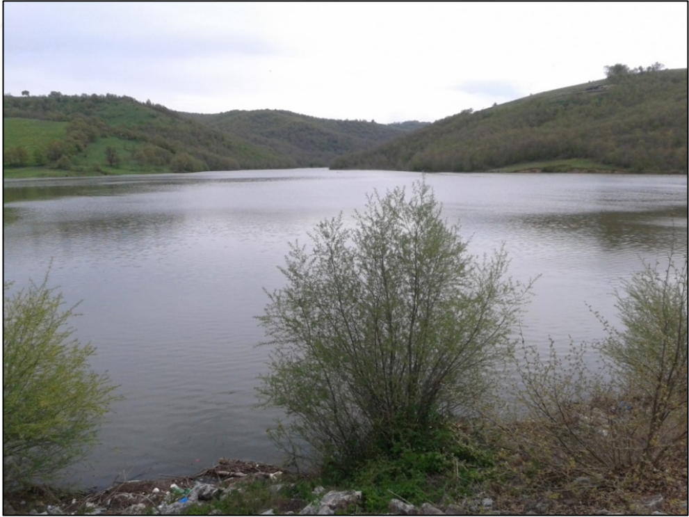
Şekil 45: Ilıca Su Toplama Tesisi kuzey yönünden görünümü. Su Toplama Tesisi yakın çevrenin su ihtiyacını karşılamaktadır (150 m).
