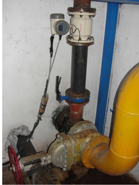
Şekil 4.20: Isı merkezi girişinde jeotermal akışkan debisi ölçümü.
