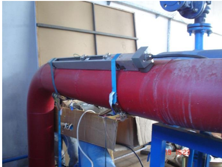
Şekil 4.22: Atatürk Caddesi ısıtma zonu eşanjör çıkışında hat debisi ölçüm çalışması.
