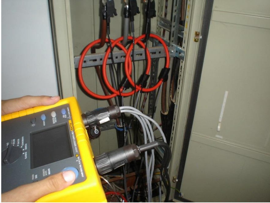
Şekil 4.23: Sirkülasyon pompalarının güç tüketim değerlerinin ölçümü.
