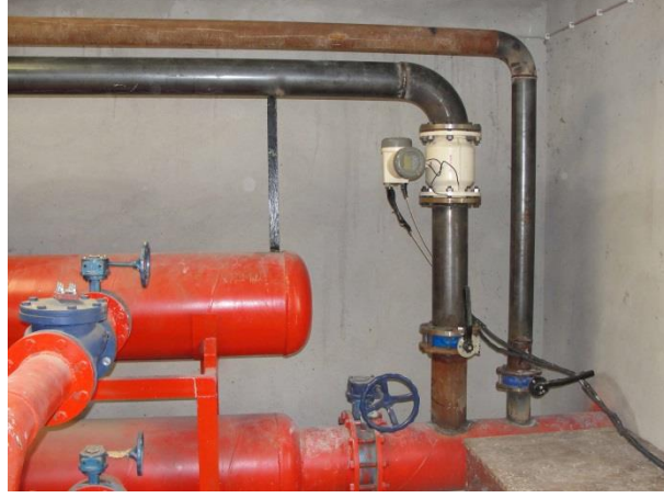
Şekil 4.19: Hisarköy isale hattı başlangıç noktasında toplam kuyu debisi ölçüm çalışması.
