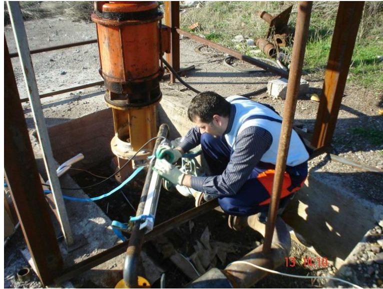
Şekil 4.18: HK-6 kuyusu kuyu başı debi ölçüm çalışması.
