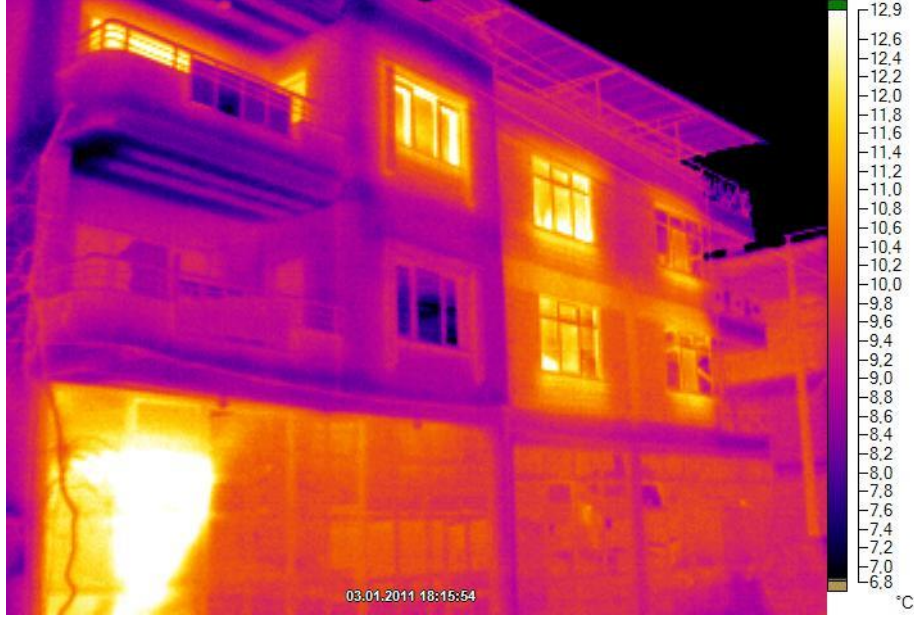
Şekil 5.7: Bigadiç JBIS’de bulunan ısı yalıtımlı ve ısı yalıtımsız bitişik iki bina.
