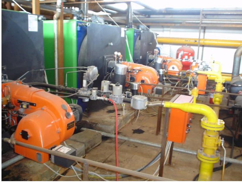
Şekil 4.11: Mart 2012'ye kadar Bigadiç JBIS'ye ısıl destek sağlayan sıcak su kazanları.
