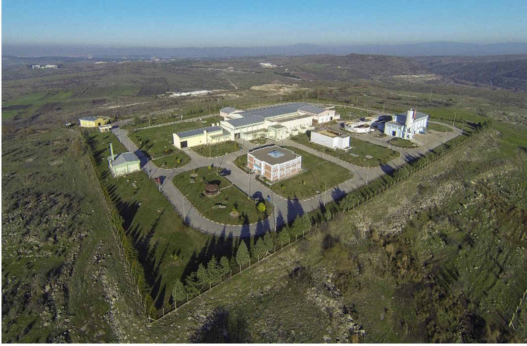
Şekil 2.4: Balıkesir merkez içmesuyu arıtma tesisi.
