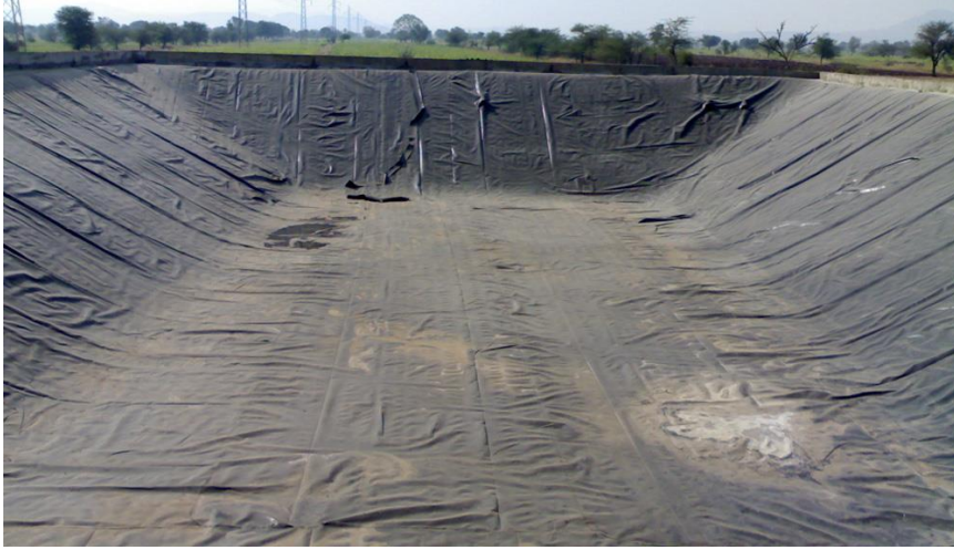
Şekil 2.2: Geomembran örneği.
