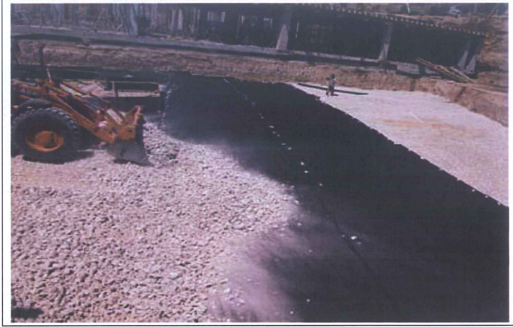
Şekil 5.1: Geotekstil üzerine dolgu tabanının serilmesi ve sıkıştırılması (M.Örnek; 2009).
