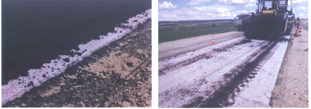
Şekil 4.5: Asfalt altı geotekstil uygulaması.(www.tencate.com ; 2014).
