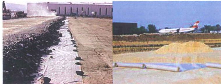
Şekil 4.2: a) Kaplamalı yollarda geotekstil uygulaması, b) Havaalanı pistlerinde geotekstil uygulaması (M. B. Benek 2006).
