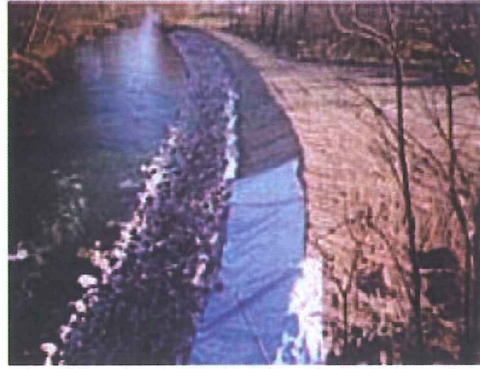
Şekil 4.9: Şev kıyı korumasında geotekstil uygulaması örnekleri (M. B. Benek 2006).
