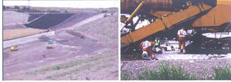
Şekil 4.1: a) Kaplamasız yollarda geotekstil uygulaması. b) Kaplamasız yollarda geotekstil uygulaması (M. B. Benek 2006).
