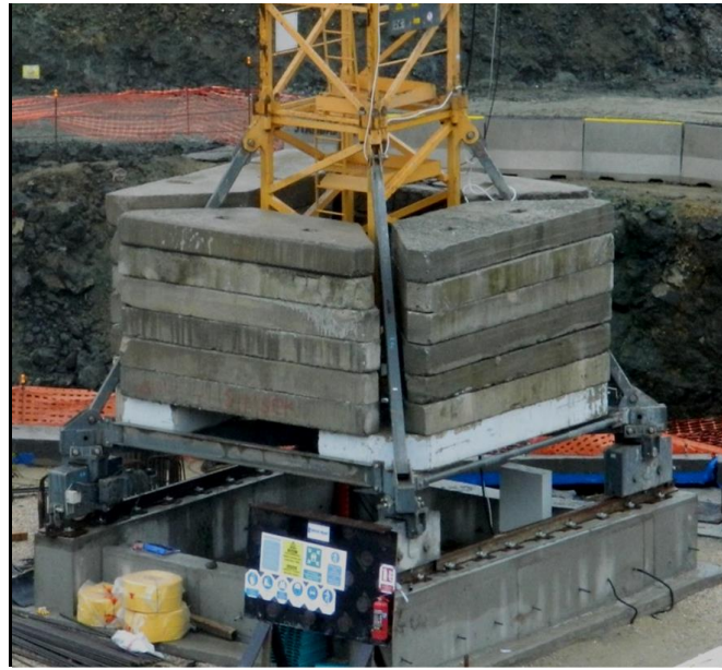
Şekil 2.16: Denge beton taşları, vincin ray sistemi.
