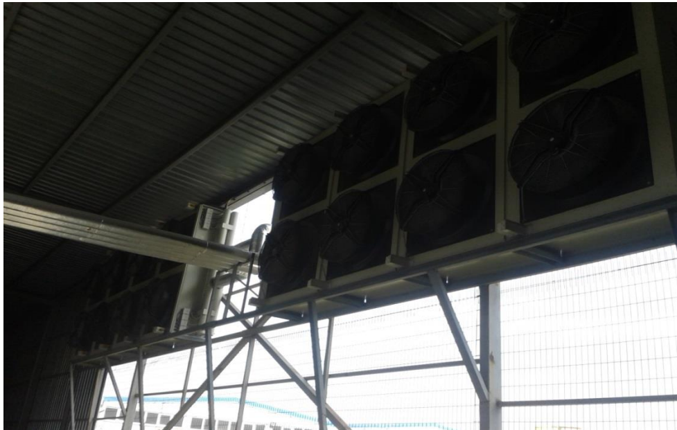
Şekil 3.7: Kuru soğutucuların görünümü
