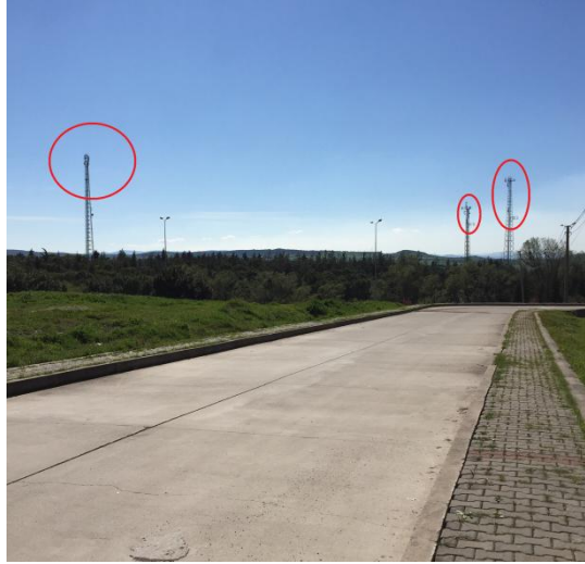
Şekil 7.2: Balıkesir Üniversitesi Çağış Yerleşkesi' nde elektrik alan değeri 1 V/m üzerinde ölçüm alınan bölgede bulunan baz istasyonları
