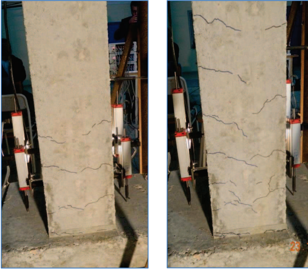
Şekil 2.22:a)%0.41 ötelenme oranında b)%1.1 ötelenme oranında hasar durumu
