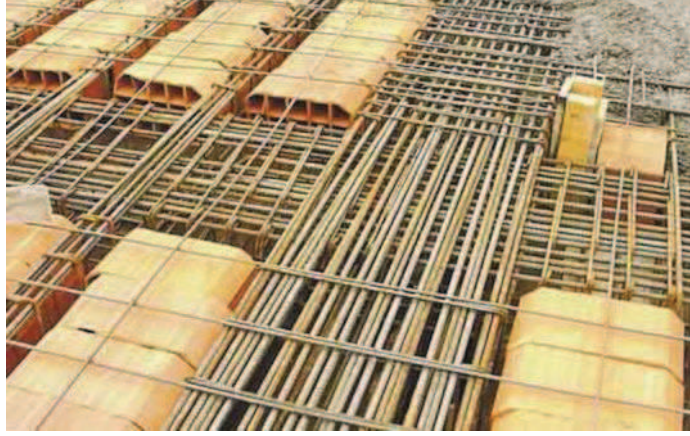
Şekil 1.3: Dişli döşemeli sistemde sığ ve geniş (yastık) kiriş [2]
