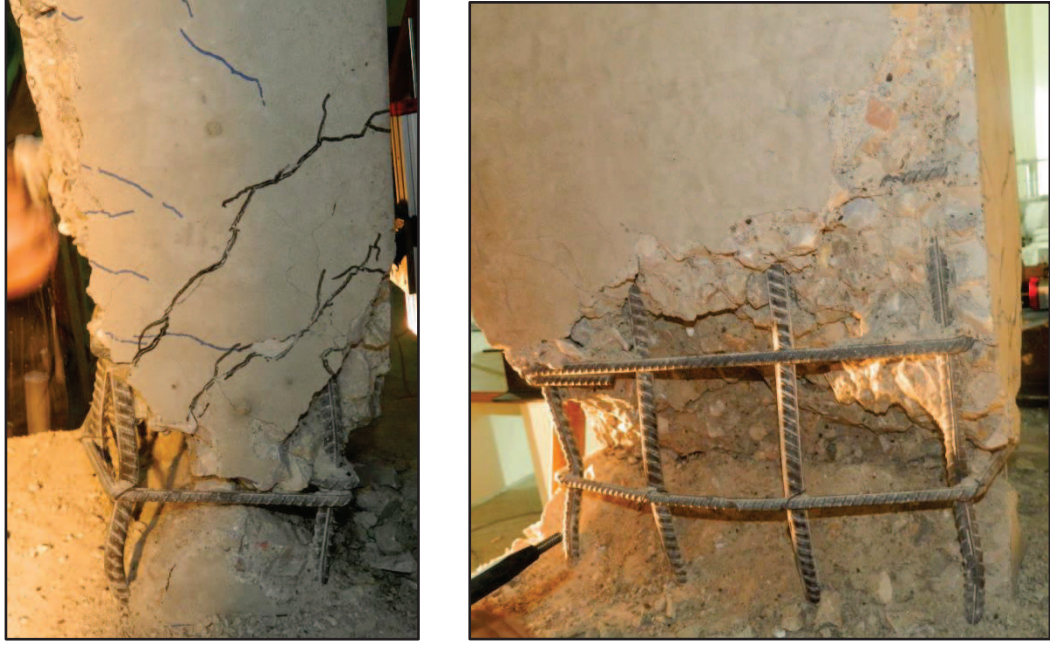
Şekil 2.18: a) Deney sonu hasar durumu b) Orta donatılarda burkulma ve beton hasarı
