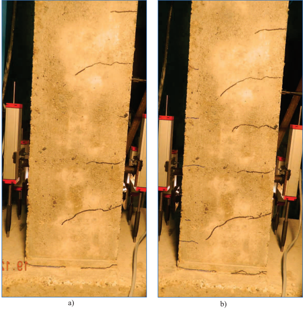
Şekil 2.40: a)%1.21 çekme ötelenme oranında b)%1.03 itme ötelenme oranında hasar durumu
