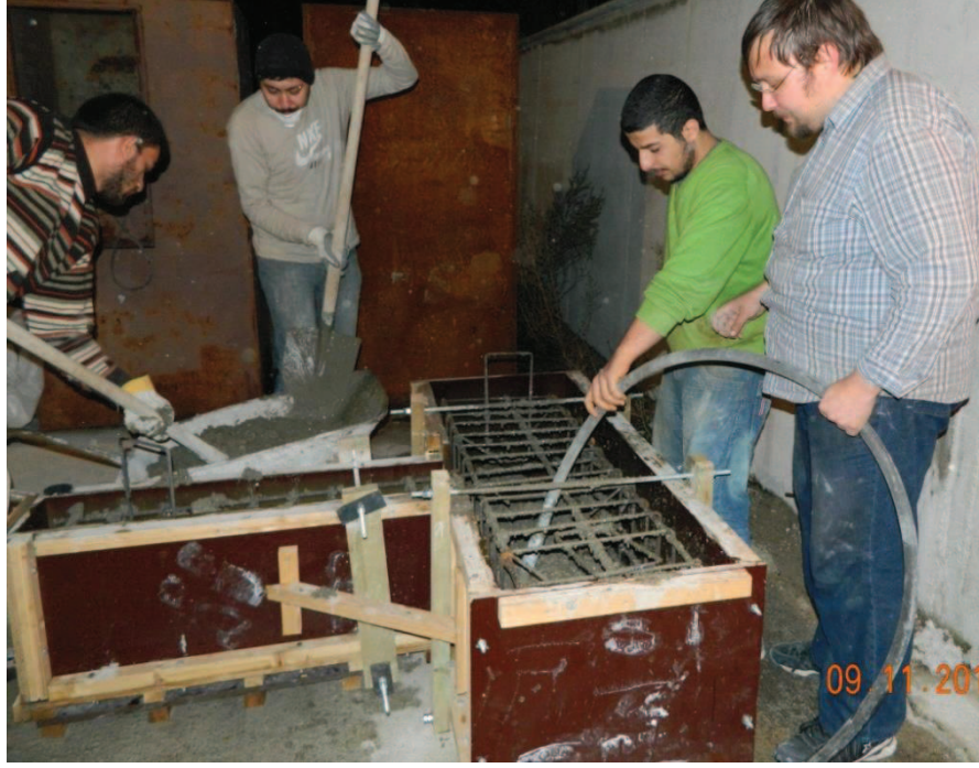
Şekil 2.7: Numune betonunun dökülmesi ve yerleştirilmesi
