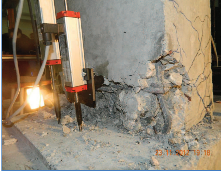
Şekil 2.24: %8.4 ötelenme oranında hasar durumu
