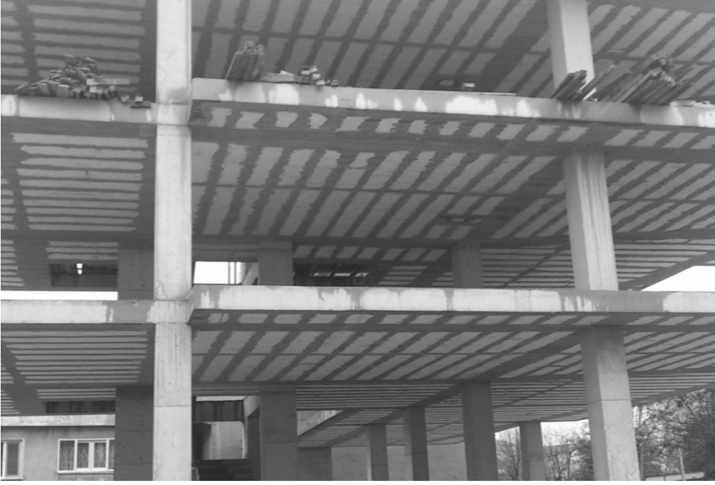
Şekil 1.2: Uygulamadan Bir Asmolen Döşeme Görünüşü
