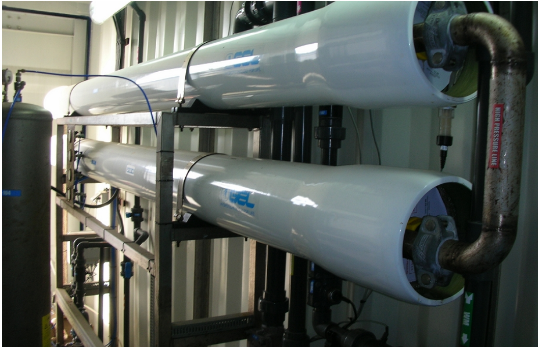
Şekil 3.7 Birinci faz ters osmoz sistemi
