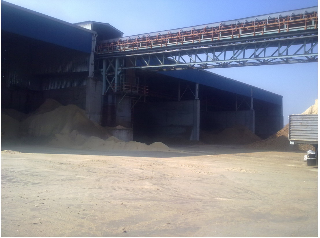
Şekil 5.5 Beton Silolar Genel Görünüm
