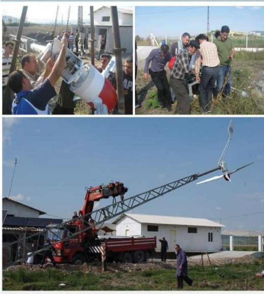
Şekil 4.6 Rüzgar türbinin montaj görüntüsü.
