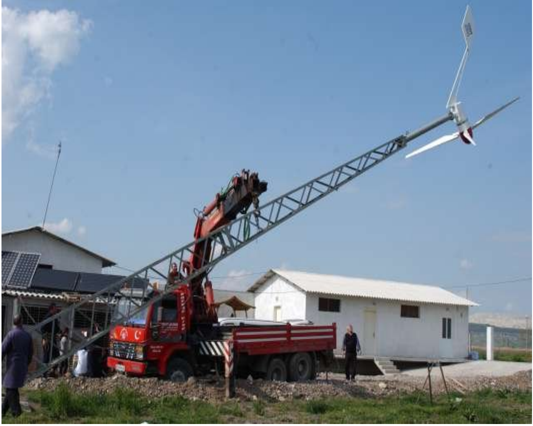
Şekil 4.4 Rüzgar türbini, ekipmanları ve direğinin montajı.
