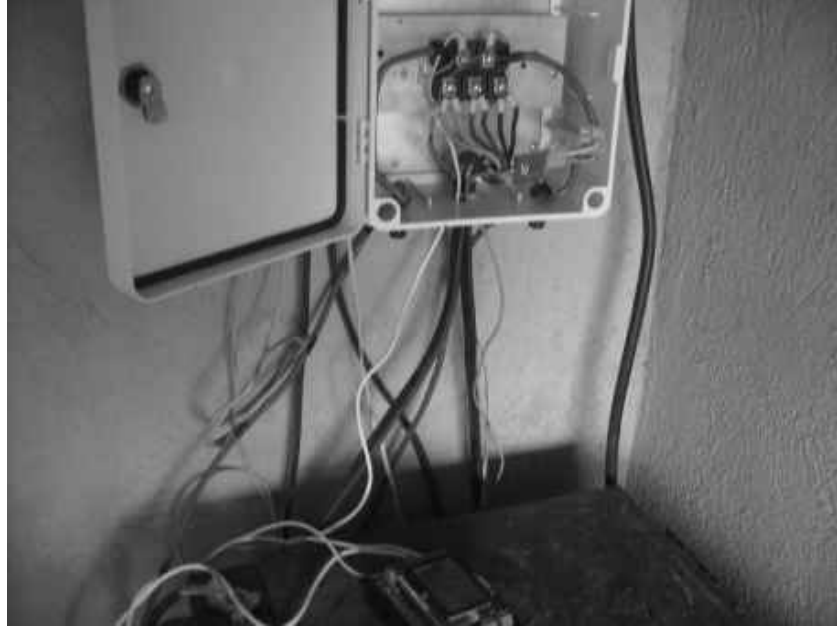
Şekil 4.9 Rüzgar türbininin akü ve ölçüm sistemine bağlantısı.
