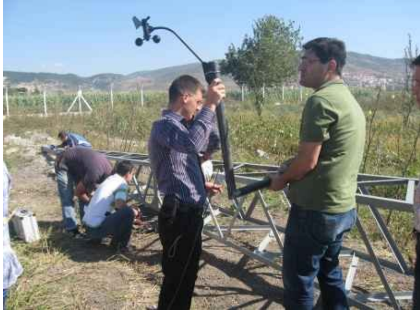
Şekil 4.10 Rüzgar hız ölçüm sisteminin montajı.
