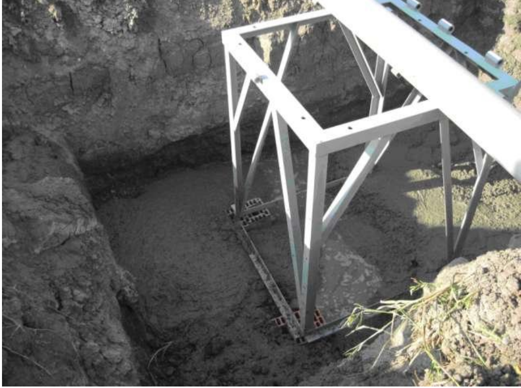
Şekil 4.3 Rüzgar türbini için hazırlanan beton kaide ve temelin yerleşimi.
