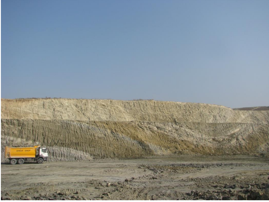
Şekil 3.1: Simav senklinalinden genel bir görünüş. Simav açık işletmesi. Bakış KD'ya doğrudur.
